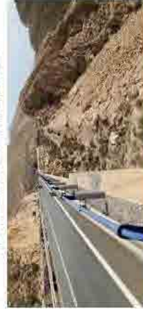
Figura 65. Sección tipo E, estructura en voladizo. (E: 2,50)
