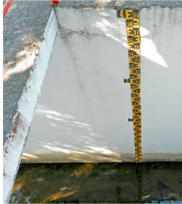
Detalle de la escala de la estación de aforo de Narila
