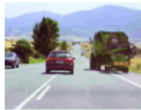
Marcas longitudinales continuas adosadas a discontinuas
