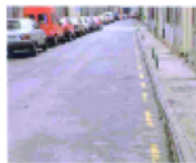
Marca amarilla longitudinal discontinua
