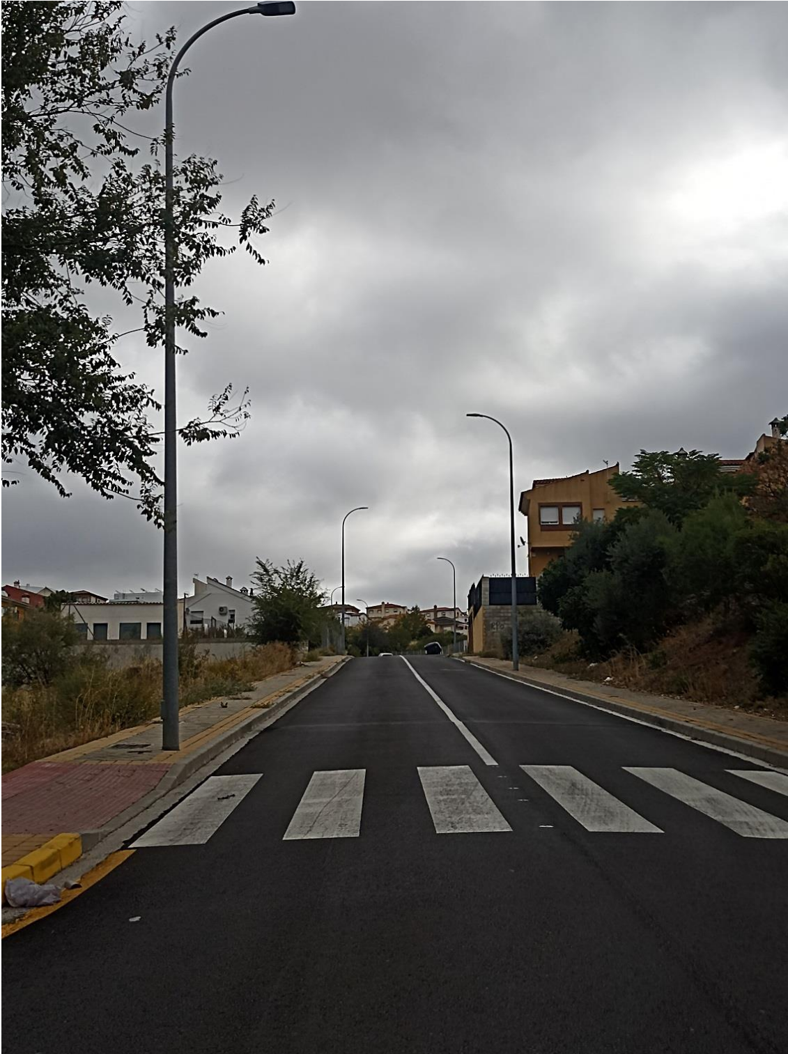
2019/2/EBCAR-260 "JUN, Reforma de alumbrado público exterior para la reducción de emisiones de CO2 en el municipio de Jun". EN EL MARCO PROYECTOS SINGULARES DE ECONOMÍA BAJA EN CARBONO PARA SER COFINANCIADOS MEDIANTE EL PROGRAMA OPERATIVO FEDER DE CRECIMIENTO SOSTENIBLE 2014-2020
