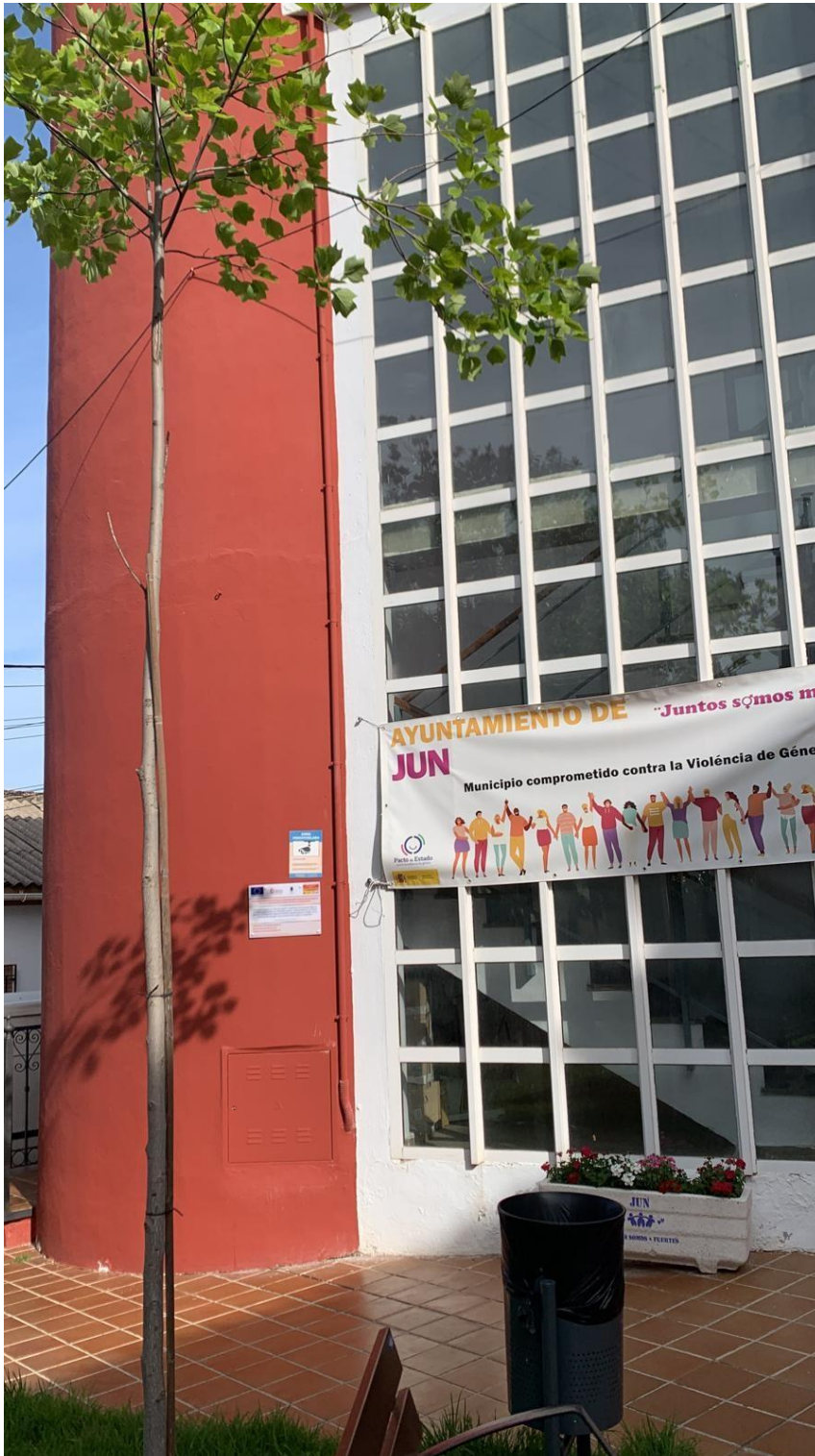
2019/2/EBCAR-260 "JUN, Reforma de alumbrado público exterior para la reducción de emisiones de CO2 en el municipio de Jun". EN EL MARCO PROYECTOS SINGULARES DE ECONOMÍA BAJA EN CARBONO PARA SER COFINANCIADOS MEDIANTE EL PROGRAMA OPERATIVO FEDER DE CRECIMIENTO SOSTENIBLE 2014-2020
