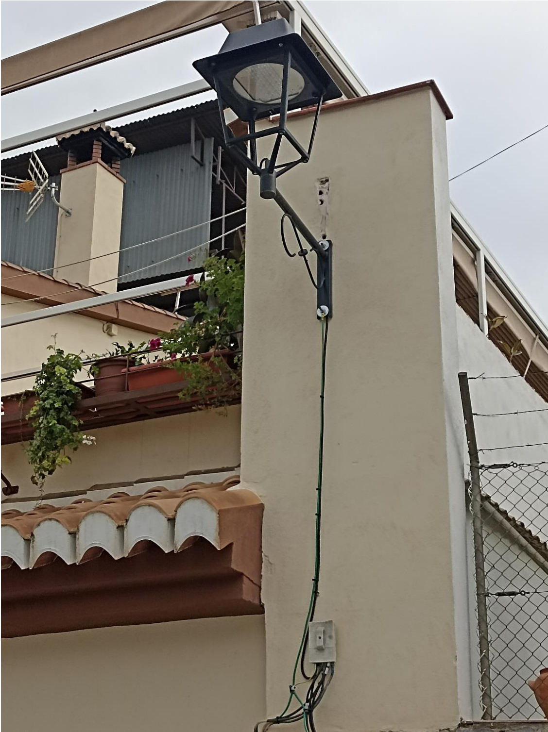
2019/2/EBCAR-260 "JUN, Reforma de alumbrado público exterior para la reducción de emisiones de CO2 en el municipio de Jun". EN EL MARCO PROYECTOS SINGULARES DE ECONOMÍA BAJA EN CARBONO PARA SER COFINANCIADOS MEDIANTE EL PROGRAMA OPERATIVO FEDER DE CRECIMIENTO SOSTENIBLE 2014-2020
