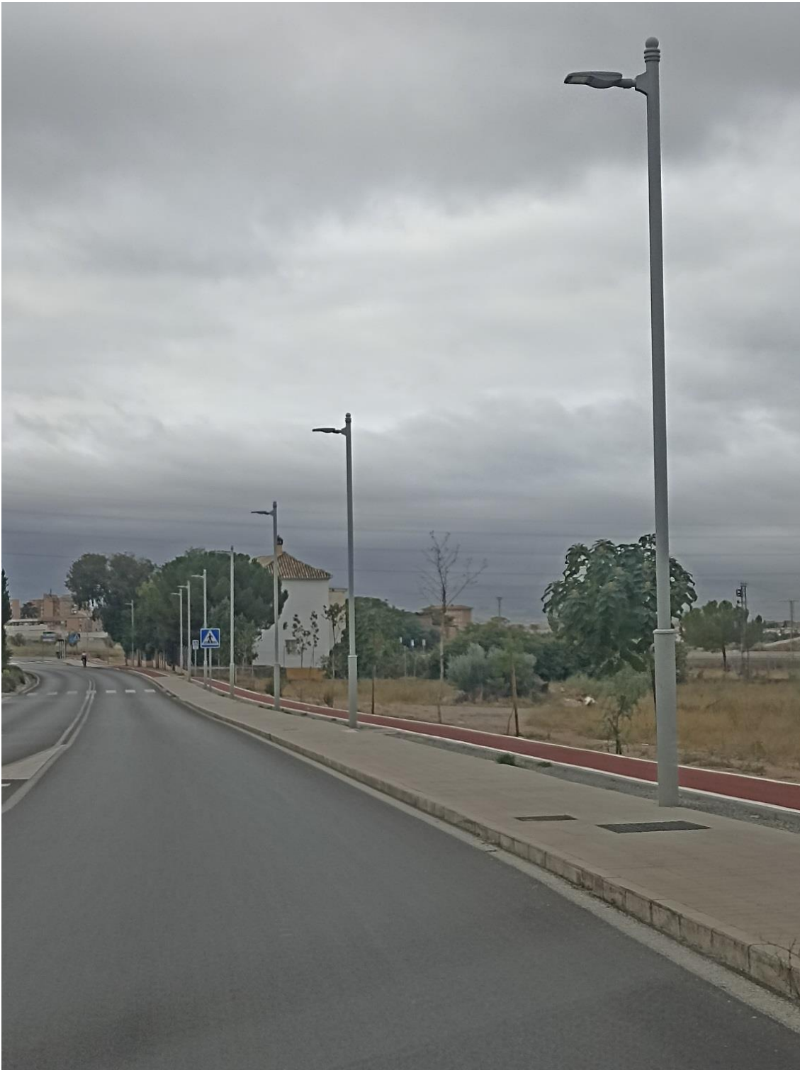
2019/2/EBCAR-260 "JUN, Reforma de alumbrado público exterior para la reducción de emisiones de CO2 en el municipio de Jun". EN EL MARCO PROYECTOS SINGULARES DE ECONOMÍA BAJA EN CARBONO PARA SER COFINANCIADOS MEDIANTE EL PROGRAMA OPERATIVO FEDER DE CRECIMIENTO SOSTENIBLE 2014-2020
