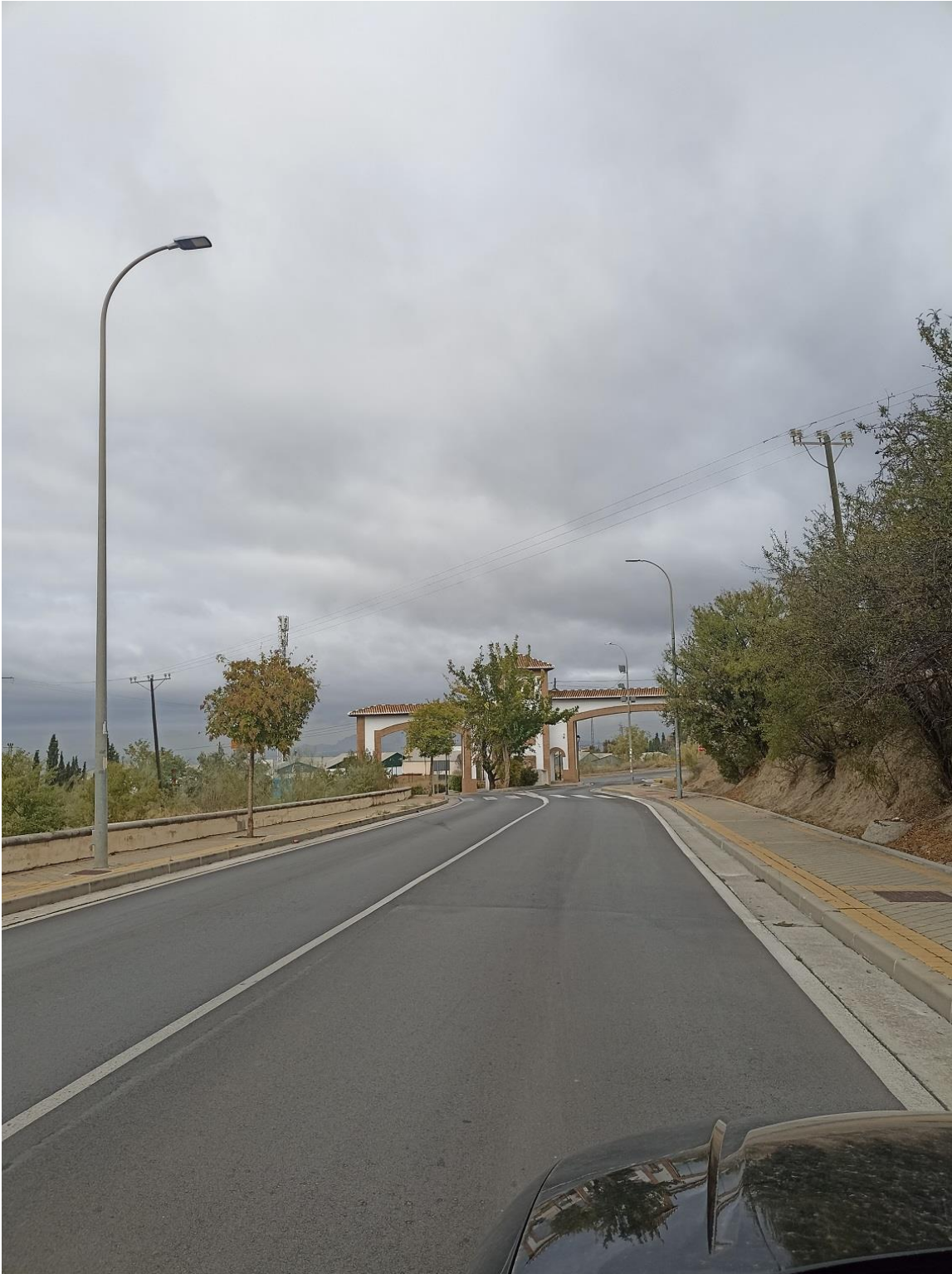
2019/2/EBCAR-260 "JUN, Reforma de alumbrado público exterior para la reducción de emisiones de CO2 en el municipio de Jun". EN EL MARCO PROYECTOS SINGULARES DE ECONOMÍA BAJA EN CARBONO PARA SER COFINANCIADOS MEDIANTE EL PROGRAMA OPERATIVO FEDER DE CRECIMIENTO SOSTENIBLE 2014-2020
