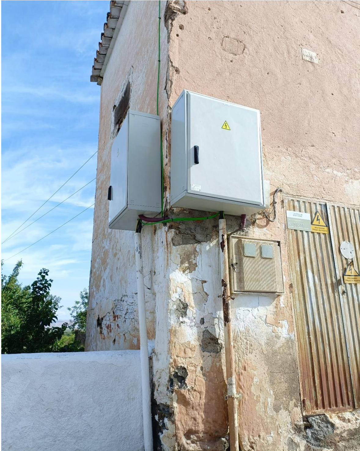
2019/2/EBCAR-52 "FERREIRA, Reducción de emisiones CO2 en el alumbrado público exterior del municipio de Ferreira por aplicación de tecnologías eficientes energéticamente". EN EL MARCO PROYECTOS SINGULARES DE ECONOMÍA BAJA EN CARBONO PARA SER COFINANCIADOS MEDIANTE EL PROGRAMA OPERATIVO FEDER DE CRECIMIENTO SOSTENIBLE 2014-2020
