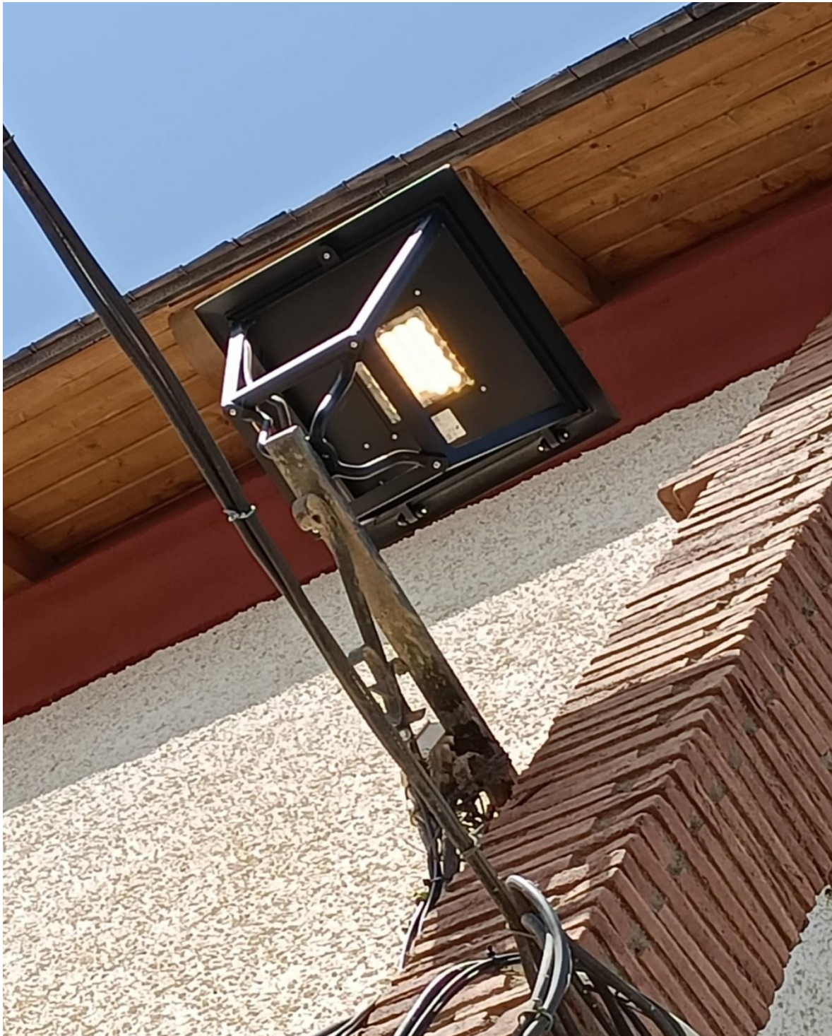
2019/2/EBCAR-52 "FERREIRA, Reducción de emisiones CO2 en el alumbrado público exterior del municipio de Ferreira por aplicación de tecnologías eficientes energéticamente". EN EL MARCO PROYECTOS SINGULARES DE ECONOMÍA BAJA EN CARBONO PARA SER COFINANCIADOS MEDIANTE EL PROGRAMA OPERATIVO FEDER DE CRECIMIENTO SOSTENIBLE 2014-2020
