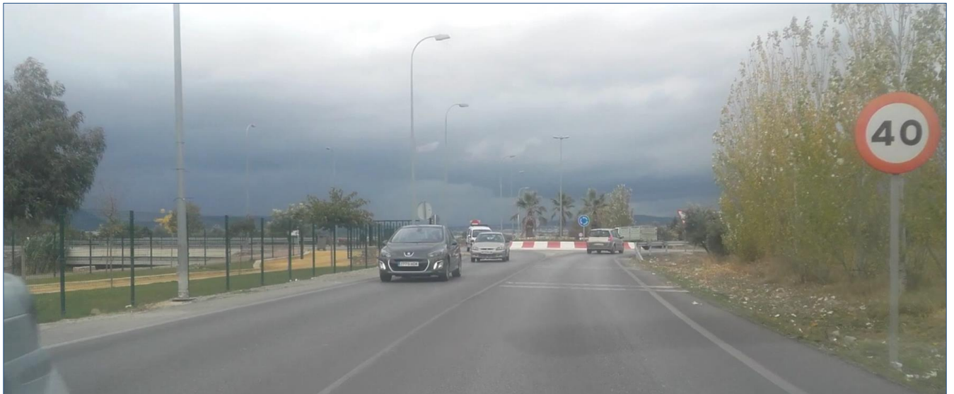
Foto 2: Sentido descendente de la zona final del trazado. Vía de doble sentido, con un carril por sentido. Velocidad de circulación limitada a 40 Km/h. Sin edificaciones en ambos márgenes de la vía.
