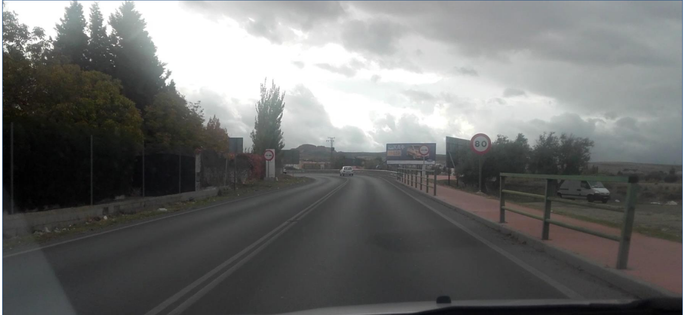
Foto 1: Sentido ascendente de la zona inicial del trazado. Vía de doble sentido, con un carril por sentido. Velocidad de circulación 80 Km/h. Sin edificaciones en ambos márgenes de la vía.
