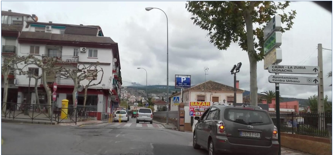
Foto 1: Sentido ascendente de la zona de único sentido en Huétor Vega. Edificaciones residenciales en ambos márgenes.
