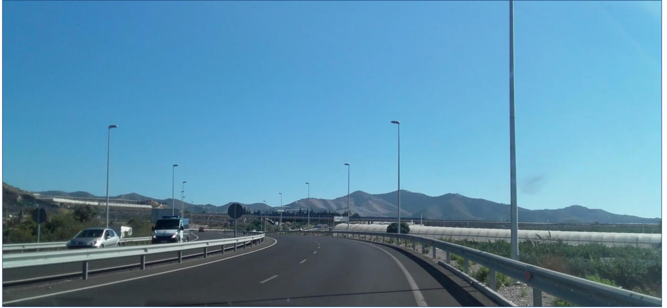
Foto 1: Sentido ascendente. Vía de dos sentidos con dos carriles por sentido. Velocidad de circulación 50 Km/h. Sin edificaciones a ambos lados de la vía.
