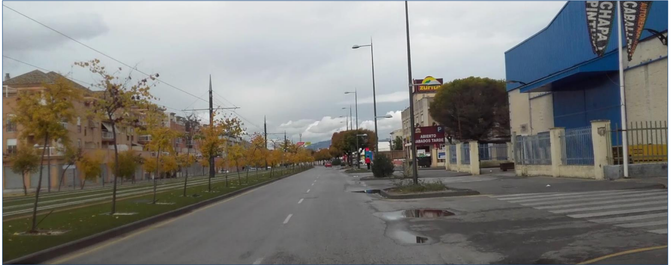
Foto 1: Sentido ascendente de la zona inicial del trazado. Vía de dos sentidos separados por la línea metropolitana, con dos carriles por sentido. Velocidad de circulación 50 Km/h. Edificaciones a ambos lados de la vía.
