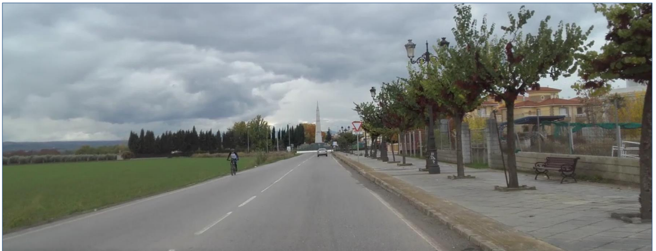
Foto 2: Sentido ascendente. Vía de doble sentido con un carril por sentido. Velocidad de circulación 50 Km/h. Edificaciones residenciales en el margen derecho de la carretera.
