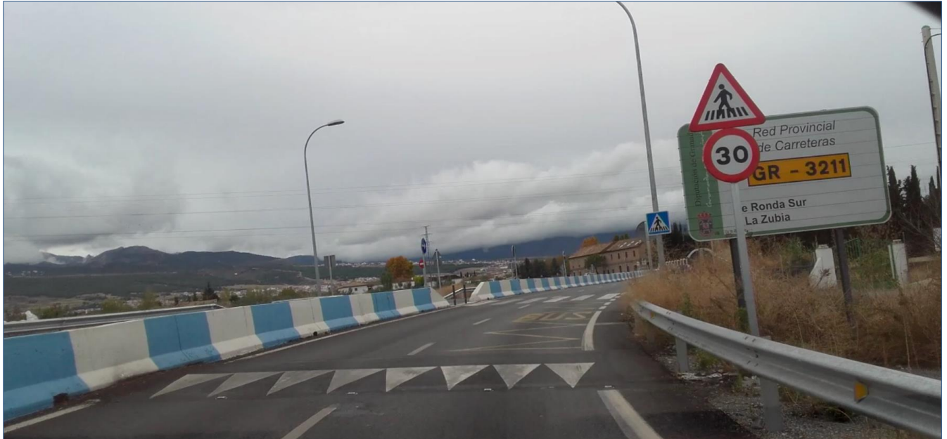
Foto 1: Sentido ascendente de la zona inicial del trazado. Vía de doble sentido, con dos carriles por sentido, separados por mediana física. Velocidad de circulación restringida a 30 Km/h por el paso de peatones. Sin edificaciones en ambos márgenes de la vía.
