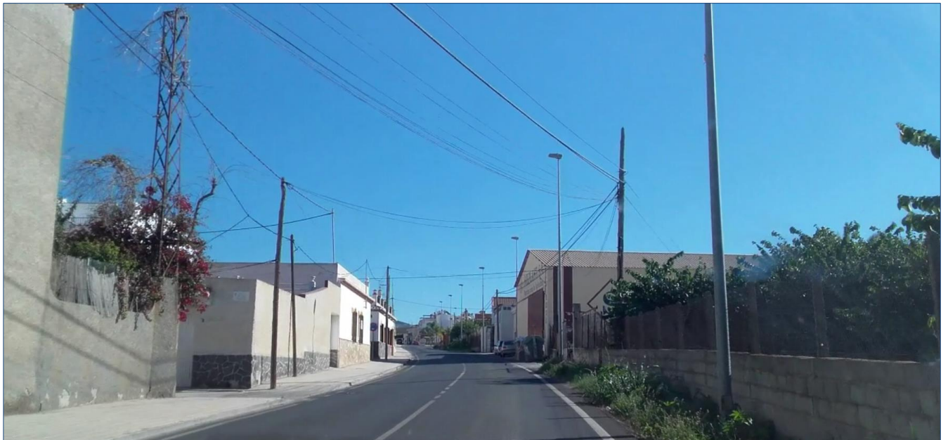
Foto 2: Sentido ascendente a su paso por la pedanía de Las Ventillas. Vía de doble sentido con un carril por sentido. Velocidad de circulación 50 Km/h. Edificaciones residenciales a ambos márgenes.
