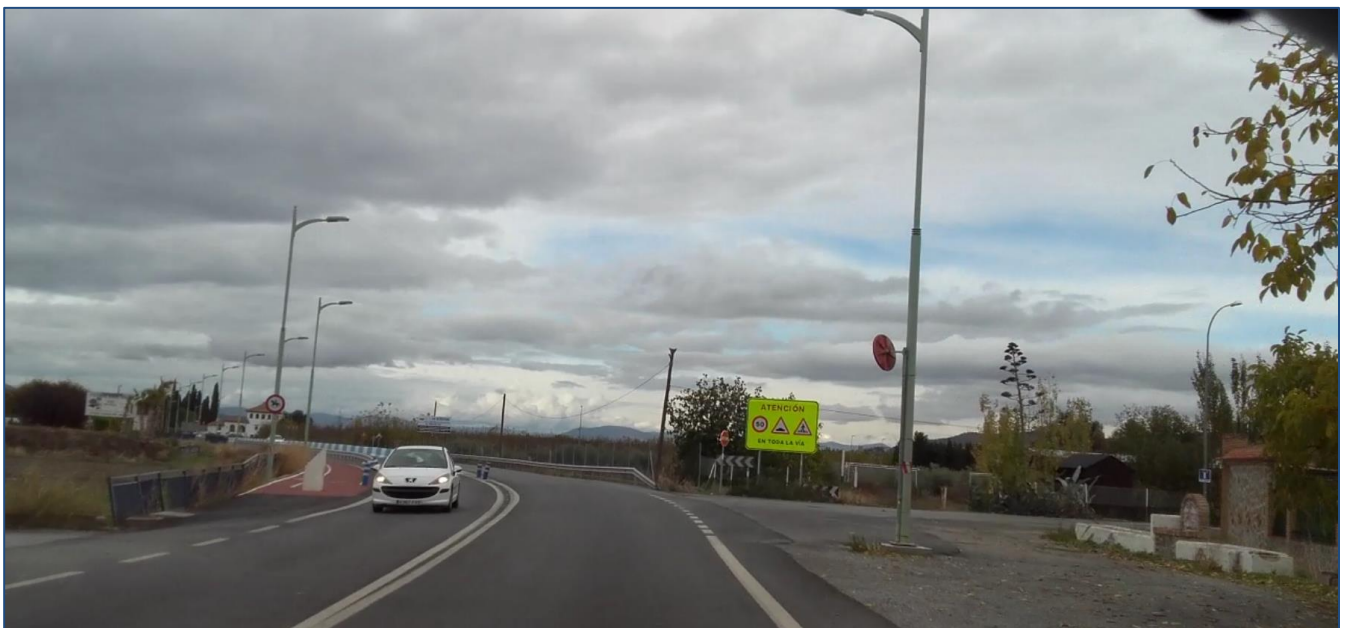
Foto 2: Sentido descendente, fin de un carril por cada sentido de circulación y comienzo de dos carriles por sentido. Velocidad de circulación de 50 Km/h.
