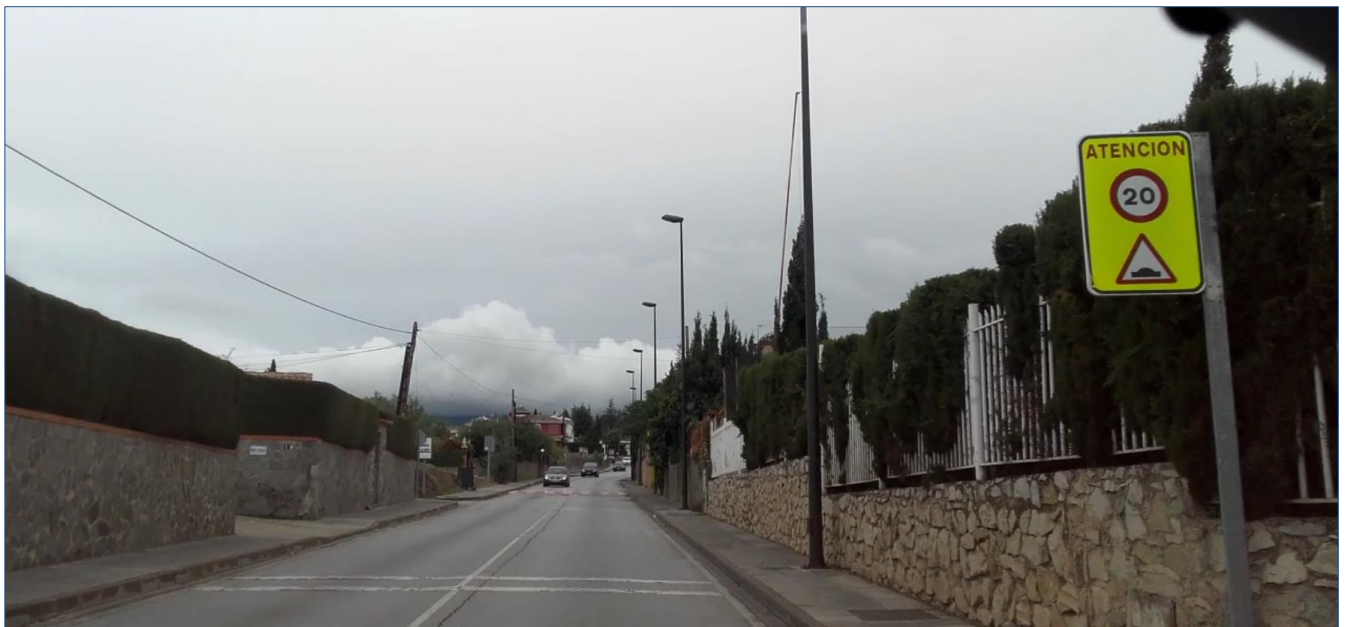
Foto 2: paso de la carretera en Gójar, en el sentido descendente. Vía de doble sentido y dos carriles por sentido. Velocidad limitada a 20 Km/h por paso de peatones sobre-elevado. Edificaciones residenciales unifamiliares en ambos márgenes.
