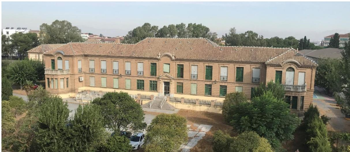
Las soluciones constructivas propuestas en la actuación son convencionales. La mejora de la eficiencia térmica de la envolvente se realiza por el interior del edificio para no afectar a la fachada de ladrillo visto. Los elementos de la envolvente afectados por la actuación son los siguientes:
