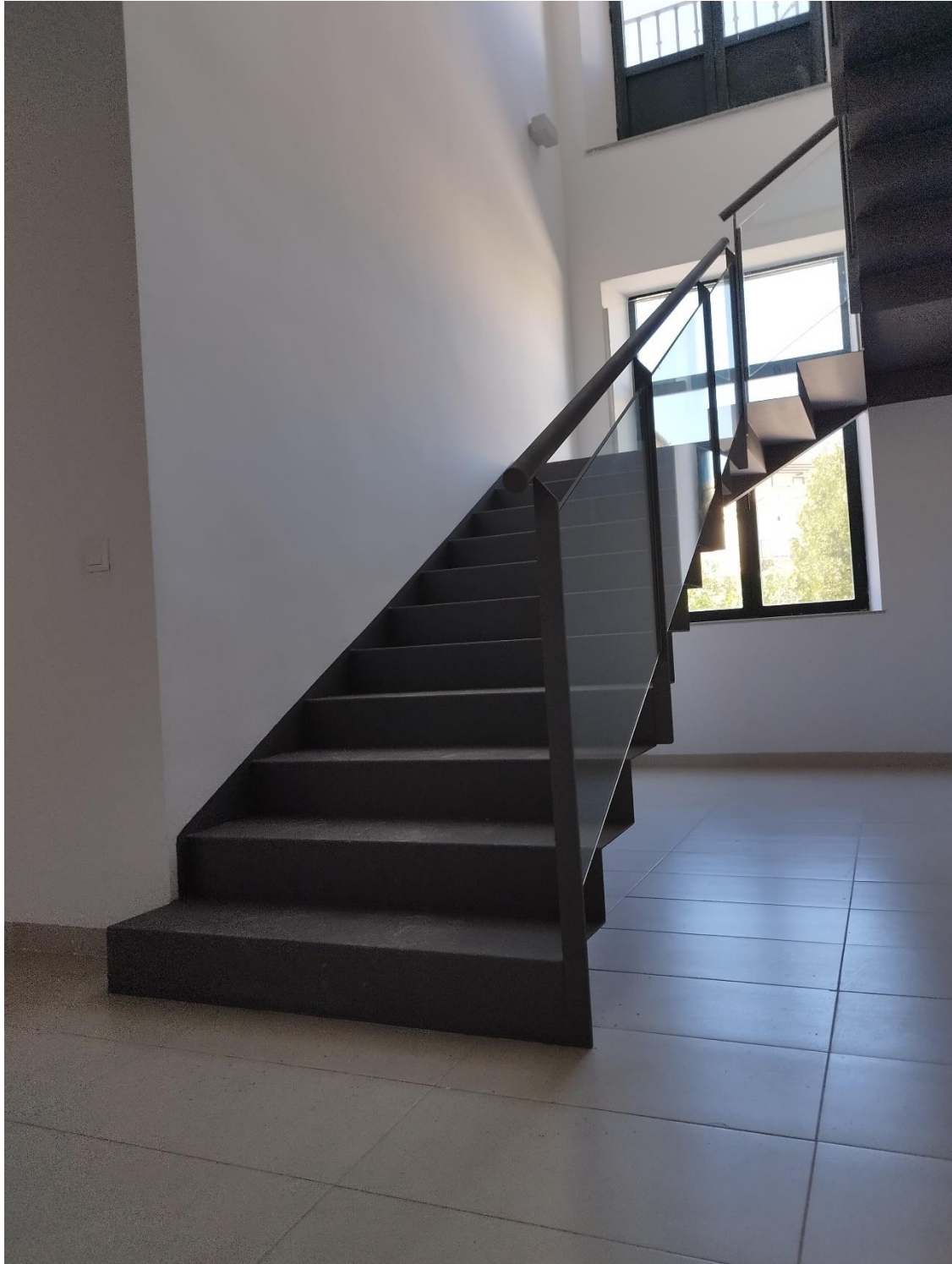
MEDIDA 1: 2021/2/REDIP/1-5 "DIPUTACIÓN, Rehabilitación Edificio "Casa Cuna". Centro La Milagrosa". MEDIDA 15: 2021/2/REDIP/1-5-2 "DIPUTACIÓN, Instalación solar fotovoltaica "Casa Cuna". Centro La Milagrosa". EN EL MARCO PROYECTOS SINGULARES DE ECONOMÍA BAJA EN CARBONO PARA SER COFINANCIADOS MEDIANTE EL PROGRAMA OPERATIVO FEDER DE CRECIMIENTO SOSTENIBLE 2014-2020
