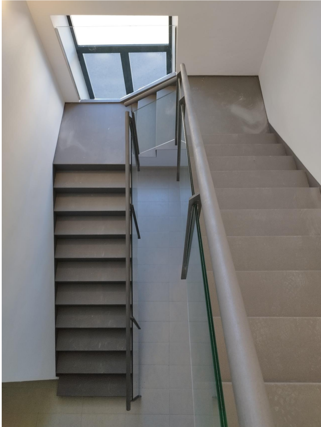
MEDIDA 1: 2021/2/REDIP/1-5 "DIPUTACIÓN, Rehabilitación Edificio "Casa Cuna". Centro La Milagrosa". MEDIDA 15: 2021/2/REDIP/1-5-2 "DIPUTACIÓN, Instalación solar fotovoltaica "Casa Cuna". Centro La Milagrosa". EN EL MARCO PROYECTOS SINGULARES DE ECONOMÍA BAJA EN CARBONO PARA SER COFINANCIADOS MEDIANTE EL PROGRAMA OPERATIVO FEDER DE CRECIMIENTO SOSTENIBLE 2014-2020
