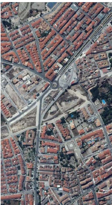
2010 Construcción de vía de borde y glorieta
