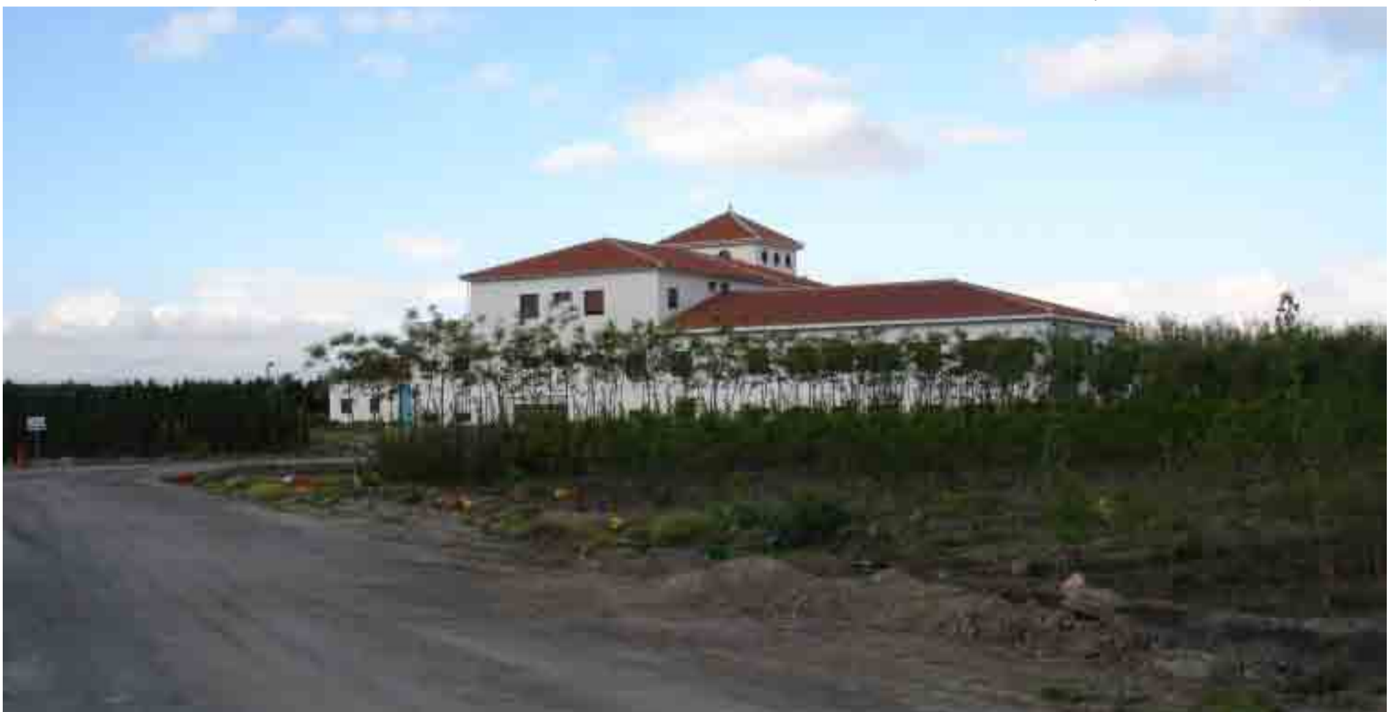
Cortijo Peinado_ edificio destinado a formación y administración
