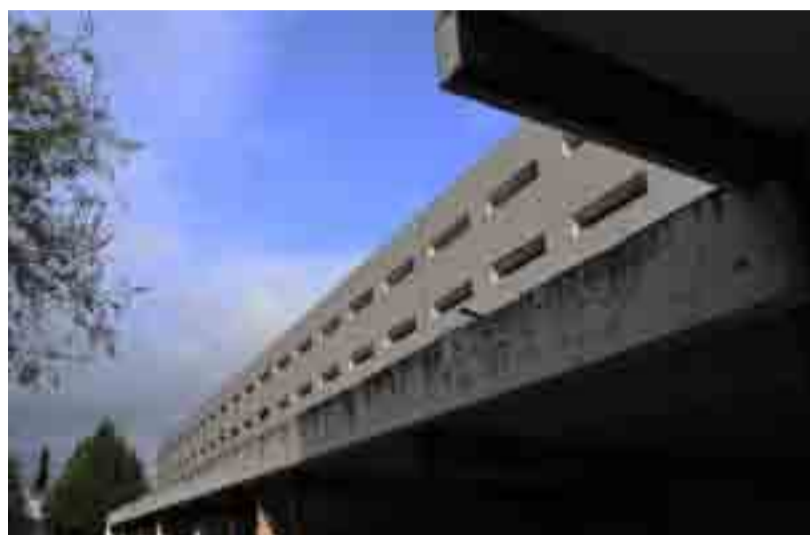
IES Luis Bueno Crespo_ vistas generales del edificio
