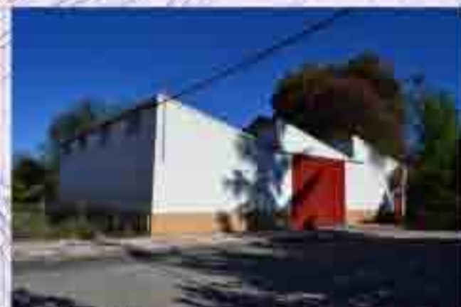
Nave de chivos y sala de ordeño de cabras
