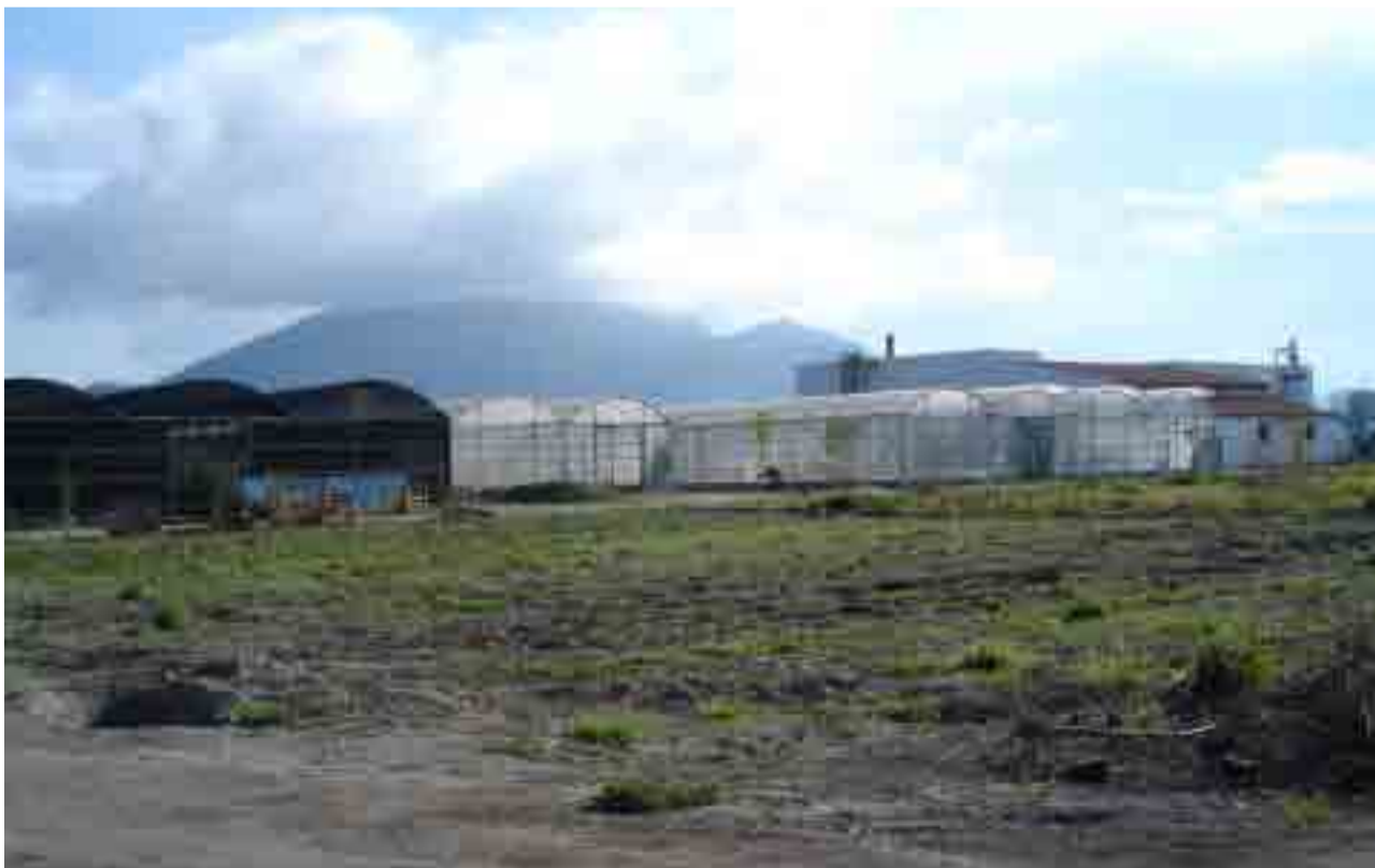
Cortijo Peinado_ umbráculos y naves multitunnel
