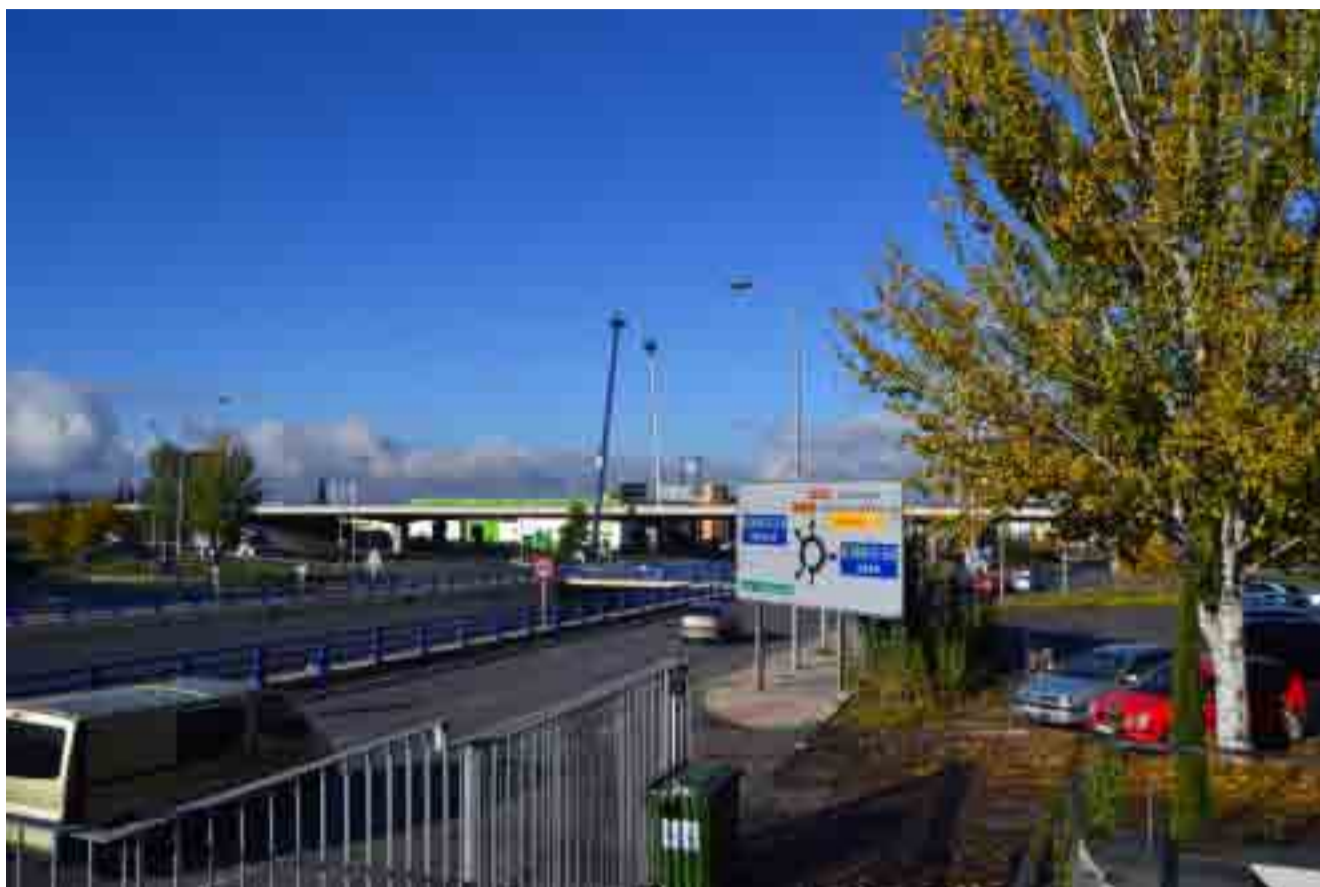
INST-1 área metropolitana_ ubicación estratégica del emplazamiento junto a vías de acceso a la ciudad
