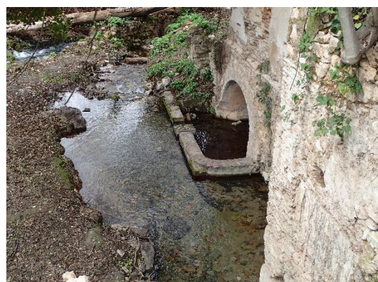
Figura 30. Restos de antiguas edificaciones relacionadas con el agua de Río Frío (molinos, batanes y martinets) salpicados de manantiales.
