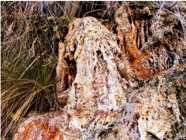
Figura 4. Precipitación de carbonato cálcico en las paredes del acueducto del Toril fosilizando las plantas que las recubren.
