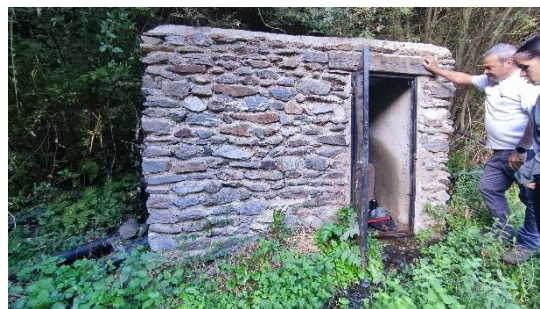
Captación de Trevélez
