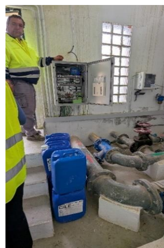
Depósito La Malahá
