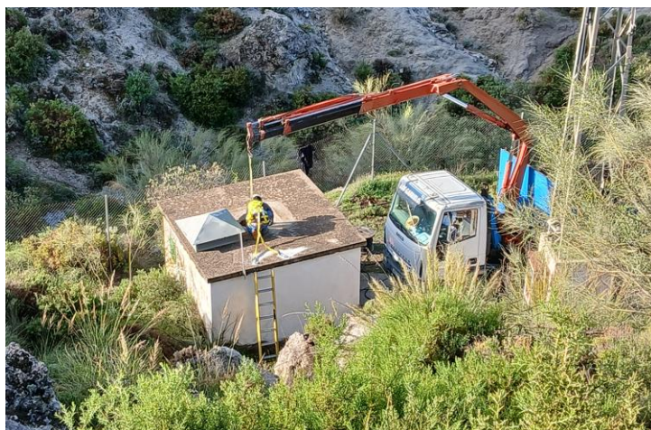
Beas de Granada (montaje tubería piezométrica y equipo de bombeo)
