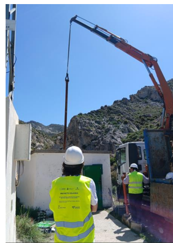
Beas de Granada (montaje tubería piezométrica y equipo de bombeo)
