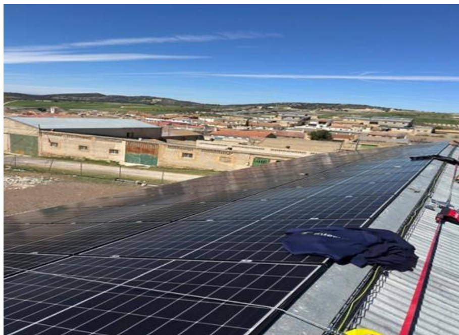
Montaje de paneles solares fotovoltaicos. Ayuntamiento de Piñar.
