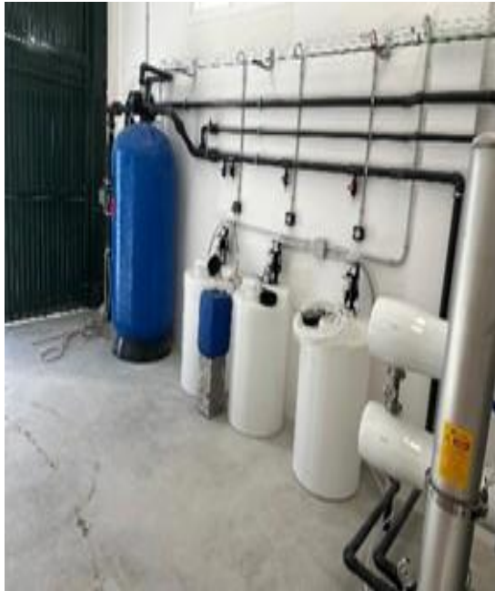
Planta de tratamiento de ósmosis inversa. Ayuntamiento de Dehesas de Guadix.
