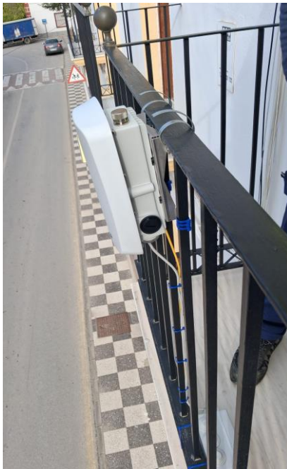
Instalación de concentradora. Ayuntamiento de Jayena y Ayuntamiento de Cúllar.
