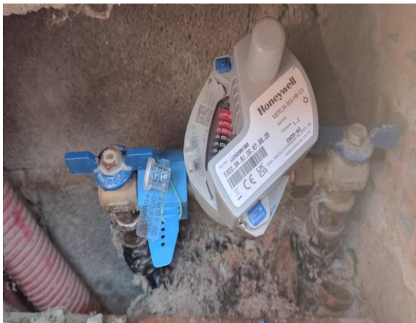
Nuevos contadores instalados y módulos de tele-lectura. Beas de Granada
