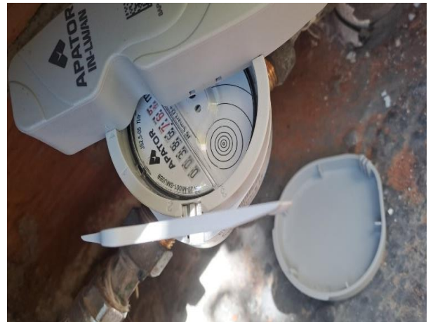
Nuevos contadores instalados y módulos de tele-lectura. Beas de Granada
