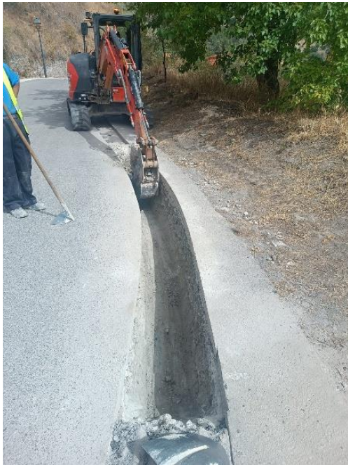
Ejecución de zanja Agrón
