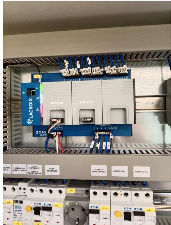
Cuadro nuevo con sus diferentes componentes EBAR. Sofrel. Ayuntamiento de Zafarraya
