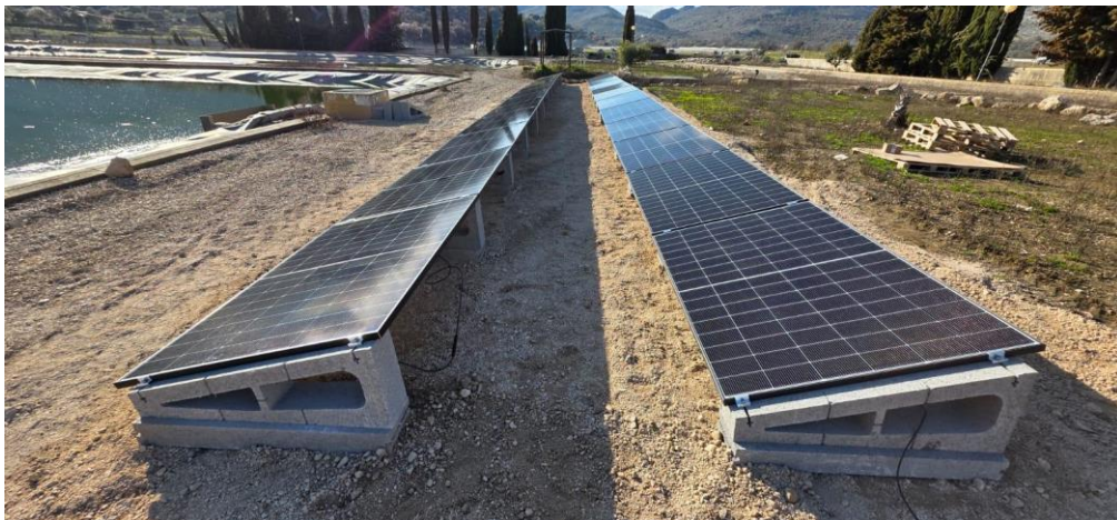
Montaje de paneles solares fotovoltaicos en la EDAR de Zafarraya.
