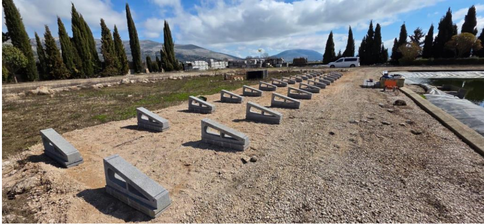
Preparación soportes para paneles solares fotovoltaicos en la EDAR de Zafarraya.
