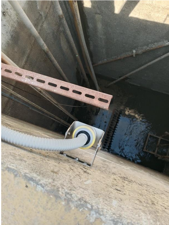
Transductor sonda EBAR. Cuadro de instalación. Ayuntamiento de Zafarraya
