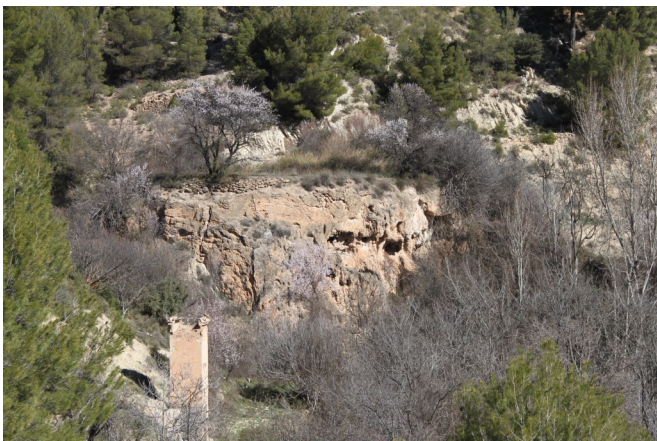
Plataforma de travertinos en la fábrica de la luz de Huéscar
