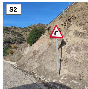
Señal 2. Señalización margen izquierdo (sentido Sorvilán), junto a cuneta existente
