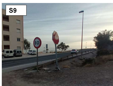
Señal 9. Señalización de STOP para el acceso a la N-340 desde el Camino Sorvilán. Poste de limitación de velocidad en la N-340 y luminaria de la N-340 con arqueta de registro.
