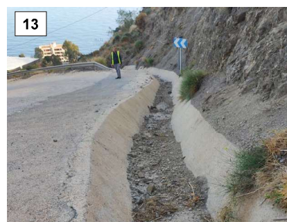
Foto 13. Cuneta trapezoidal margen derecho sentido N-340.
