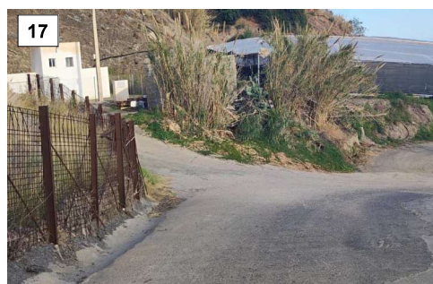
Foto 17. PK 0+550 a 0+600. Fotografía tomada en sentido hacia N-340. Cuneta existente en el margen izquierdo que se ve interrumpida por el doble acceso a parcelas donde habrá que proyectar dos tramos de salvacunetas.
