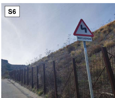
Señal 6. Señalización junto a cuneta. Fotografía tomada en sentido hacia Sorvilán. PK 0+530
