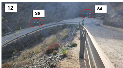
Foto 12. Tramo PK 0+400 a PK 0+450
