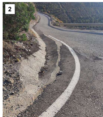
Foto 2. Inicio Cuneta existente margen izquierdo
