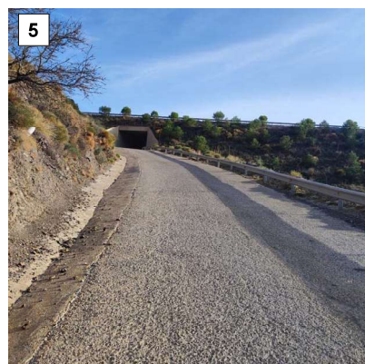
Foto 5. Se observa tramo entre PK 0+100 y PK 0+200 con cuneta existente margen izquierdo (sentido Sorvilán) y al fondo (PK 0+200) cruce bajo la A-7. Se observa bionda en todo el tramo en el margen derecho.
