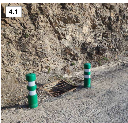
Foto 4.1. Pozo de inicio ODT1. Punto bajo del trazado entre PK 0+000 al PK 0+200.
