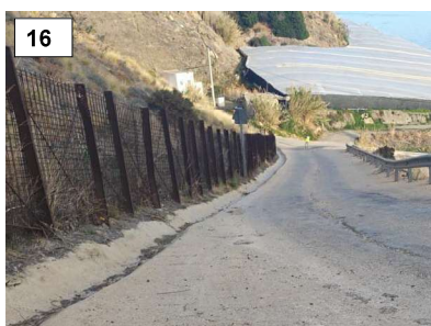
Foto 16. PK 0+500 a 0+600. Fotografía tomada en sentido hacia N-340. Cuneta existente en el margen izquierdo y bionda en margen derecho.
