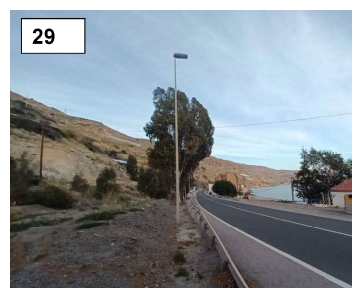
Foto 29. Luminaria en el margen izquierdo de la N-340 en sentido Almería
