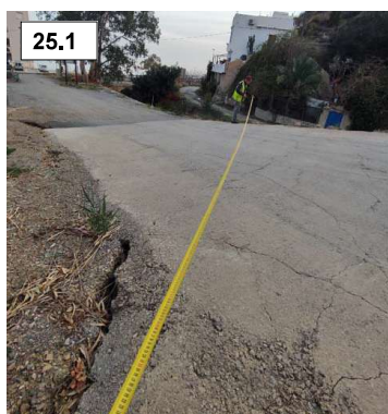
Foto 25.1. Recorrido y distancia desde la obra de entrada ODT 2 hasta la salida hacia el Barranco de los Yesos.
