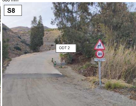
Señal 8. Señalización en margen derecho en sentido Sorvilán.
