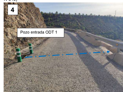
Foto 4. Se observa punto bajo en el trazado donde existe un pozo de entrada de la ODT 1 existente y donde confluye el drenaje tanto de la cuneta existente en el margen izquierdo (sentido N-340) como el drenaje que se origina desde el paso inferior en la A-7 hasta la ODT1 en sentido Sorvilán.
