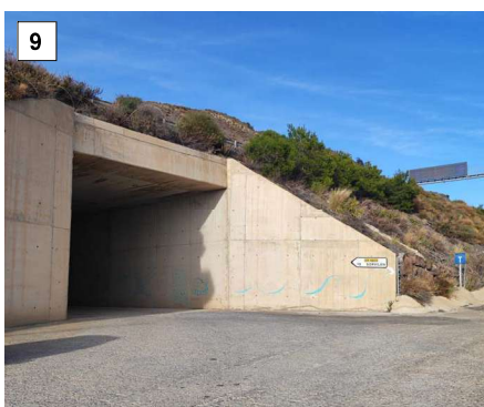
Foto 9. Vista a la salida de Obra bajo la A-7 sentido Sorvilán
