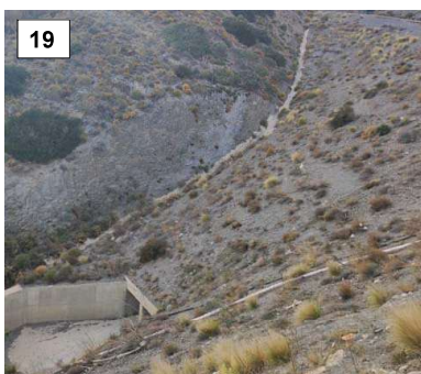
Foto 19. Barranco de los Yesos con salida de ODT que cruza la A-7
