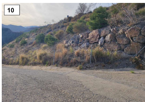
Foto 10. PK 0+265 donde se da inicio a la cuneta trapezoidal existente en el margen derecho (sentido N-340). Existe una valla de protección de la carretera A-7 entre el talud de la vía y la cuneta.
