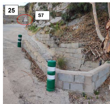
Foto 25. Obra de entrada ODT 2 en PK 0+805 margen derecho en sentido Sorvilán
