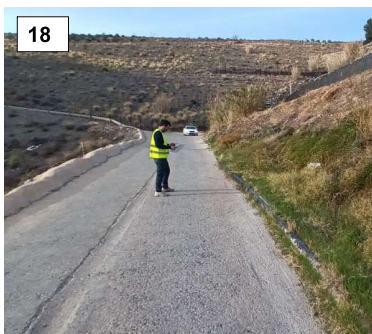
Foto 18. Fotografía tomada desde el PK 0+630 en sentido hacia Sorvilán. Se observa talud en el margen derecho desprovisto de cuneta y con presencia de una tubería al borde de la calzada de PE100 PN16 ø160 mm de la comunidad de regantes. No existe biondas en el lado del Barranco de los Yesos a partir de la ubicación donde se encuentra el vehículo (PK 0+600)
