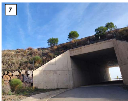
Foto 7. Obra paso inferior Camino bajo la A-7 (punto alto)
