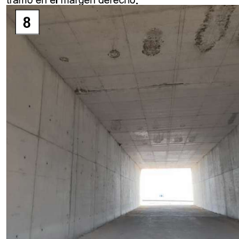
Foto 8. Obra paso inferior Camino bajo la A-7. Vista interior
