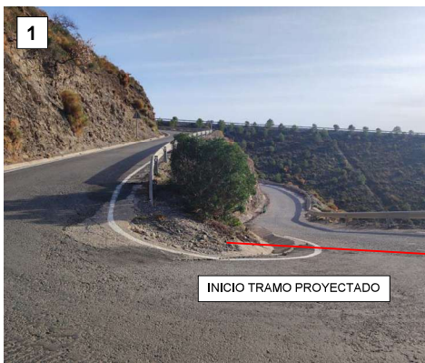
Foto 1. Inicio Tramo proyectado (PK 0+000). Cuneta existente margen izquierdo con bionda en el margen derecho.
