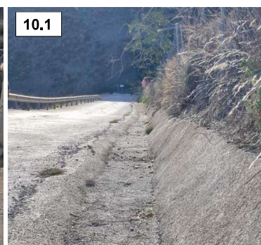
Foto 10.1. Cuneta tipo trapezoidal en margen derecho en tramo comprendido entre PK 0+265 y PK 0+470. La sección de talud interior va creciendo a medida que se avanza en el PK, ganando sección.
