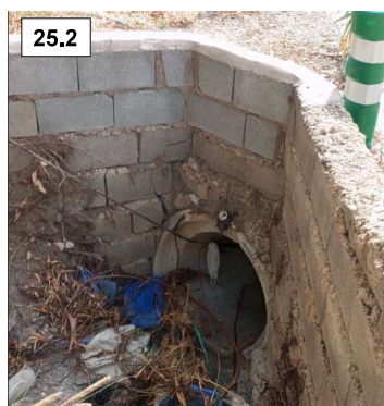
Foto 25.2. obra de entrada ODT 2. Tubo de hormigón de diámetro 800 mm
