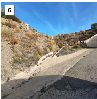
Foto 6. PK 0+175 confluencia de canal drenaje con cuenta existente
