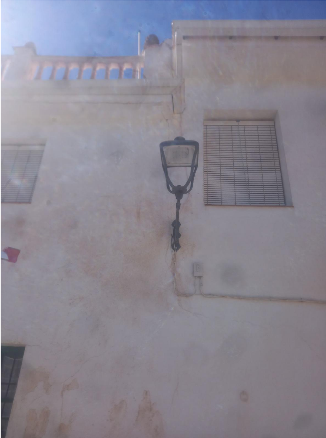
2019/2/EBCAR-160 "HUÉTOR SANTILLÁN, Reducción de emisiones de CO2 en el alumbrado público exterior del municipio de Huétor Santillán". EN EL MARCO PROYECTOS SINGULARES DE ECONOMÍA BAJA EN CARBONO PARA SER COFINANCIADOS MEDIANTE EL PROGRAMA OPERATIVO FEDER DE CRECIMIENTO SOSTENIBLE 2014-2020
