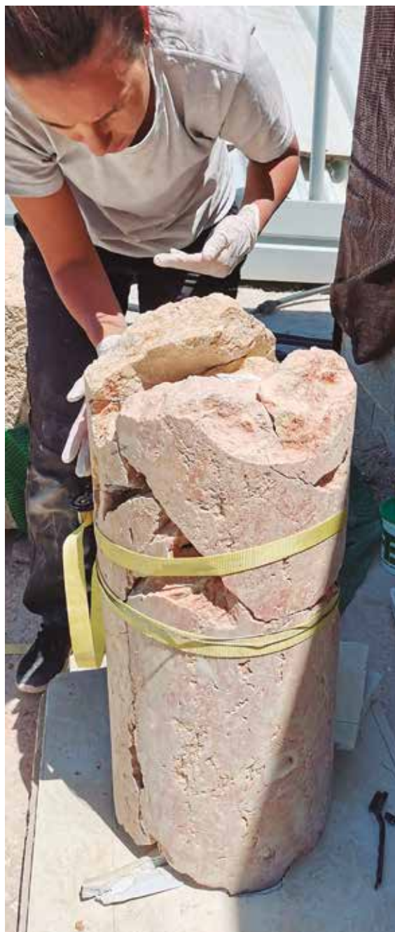
Figura 4. Proceso de unión de fragmentos de columna.
