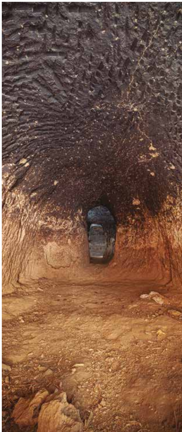
Nivel I, sala 9. Vista desde el centro de la estancia hacia la puerta que comunica con la sala 10.
