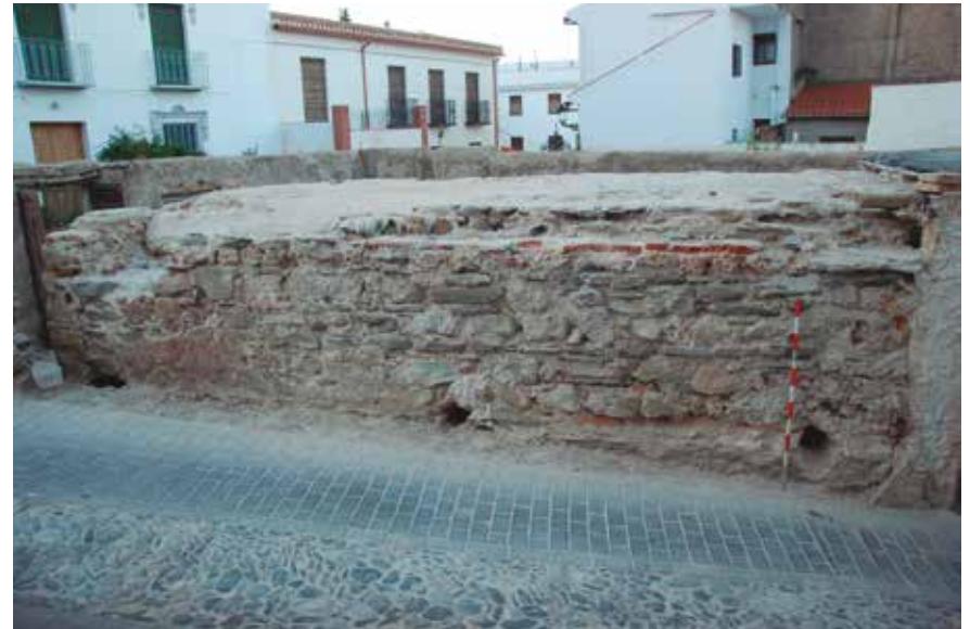
Alzado NE; Detalle del orificio de entrada de agua (izquierda) y aliviaderos (centro y derecha).
