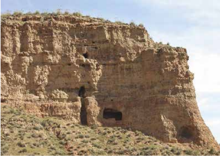
Atalaya situada en Cerro Branco (Beas), dispuesto en dos niveles con una altura total de 11,60 metros, dotado de una pequeña sala de guarda, un banco y un matacán protegiendo la chimenea de acceso.
