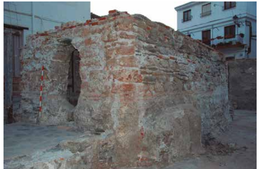
Vista General de los alzados NO y SO.
