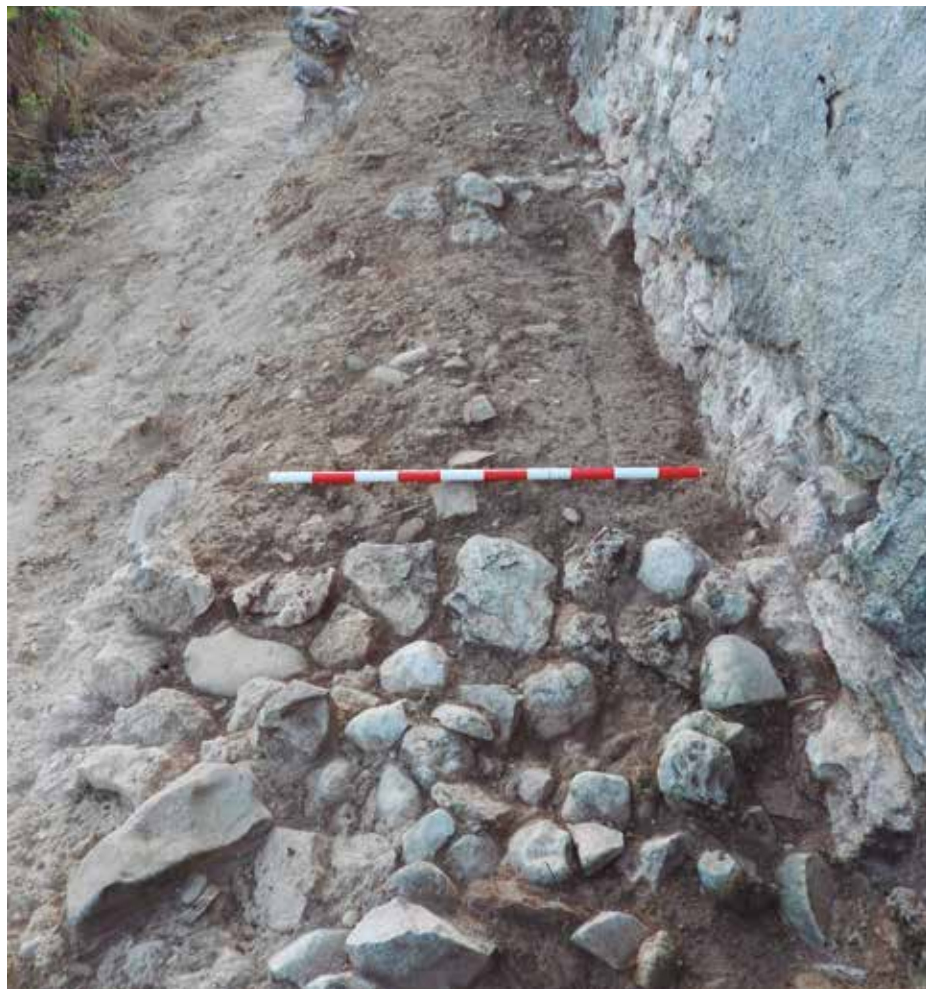
Actuaciones de conservación.
