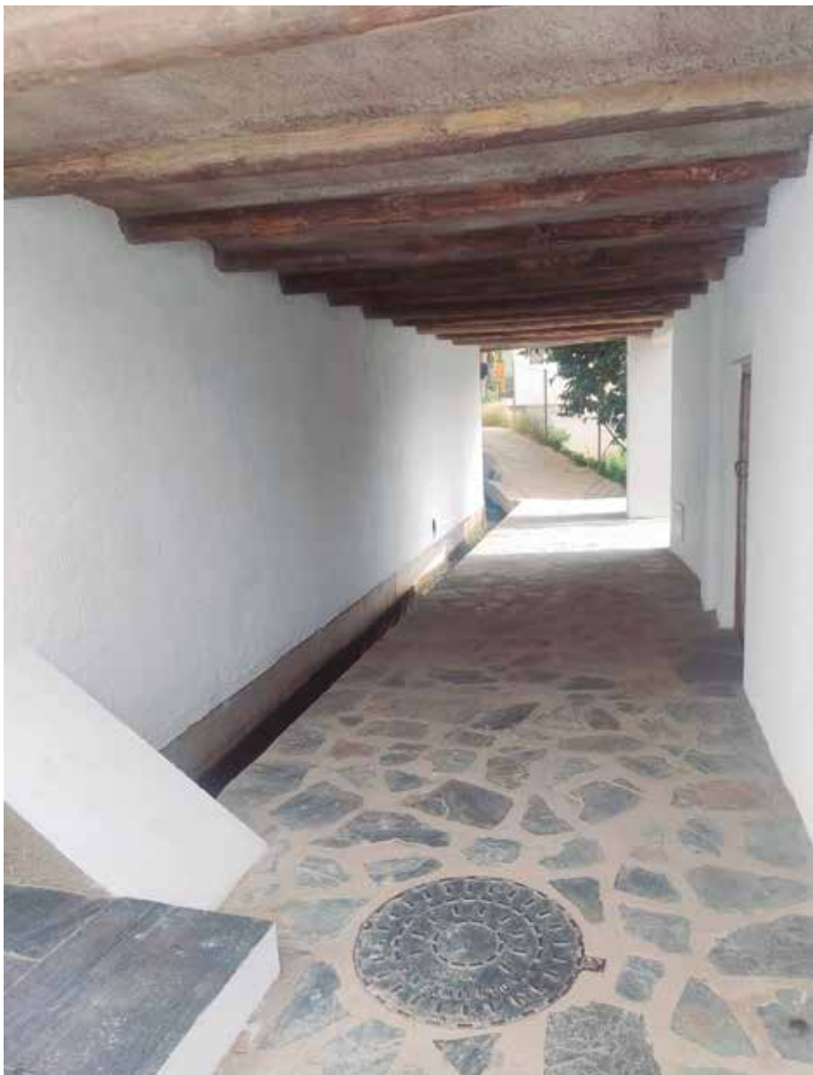
Vista del Tinao sobre la Acequia Nueva, una vez acometida la actuación.
