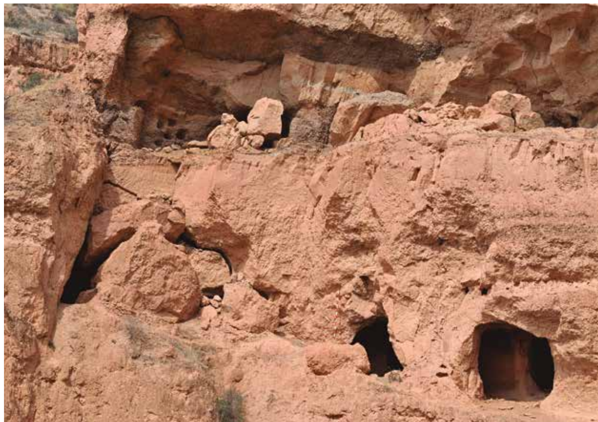
Detalle de la entrada y el palomar del segundo nivel.
