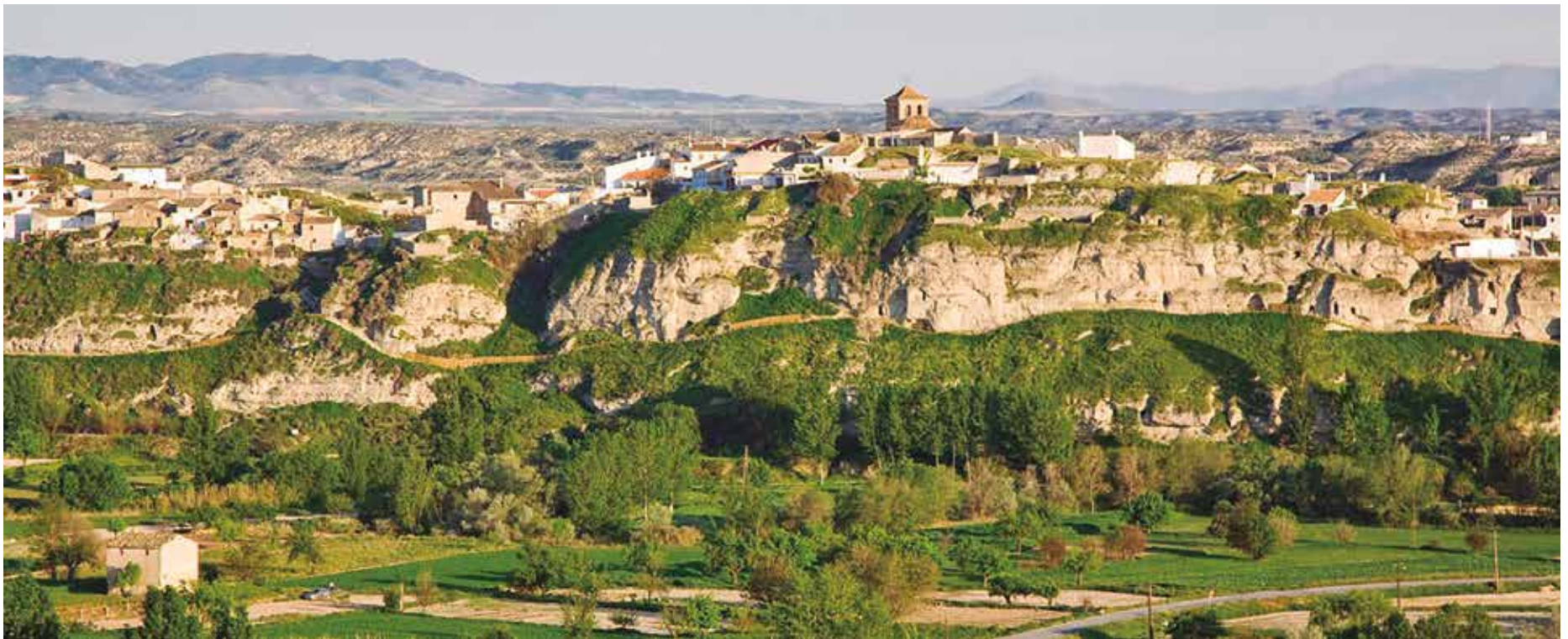
Figura 1. Vista de las casas-cueva de Benamaurel
