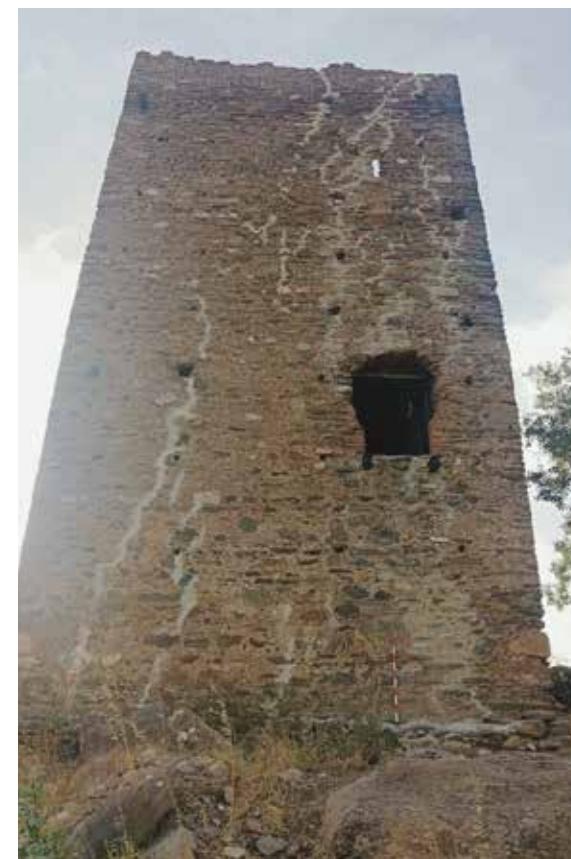
Fig. 3 cara oeste de la torre restaurada y restitución de la puerta original (Fuente: MEMOLab UGR)
