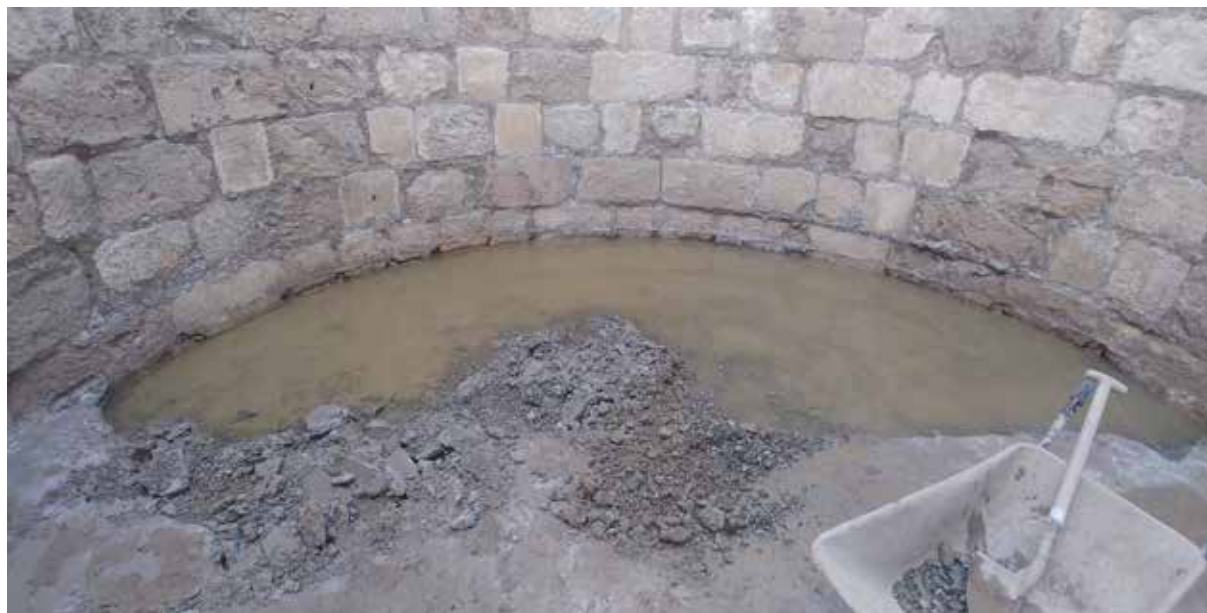
Fig. 6 Retirada progresiva de la grava hasta alcanzar el nivel sobre el que se realizó la adecuación del pavimento contemporáneo.
