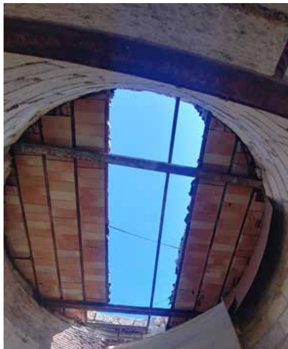
Fig. 4 Proceso de eliminación de la cubierta por cortes longitudinales desde el interior hacia los laterales.
