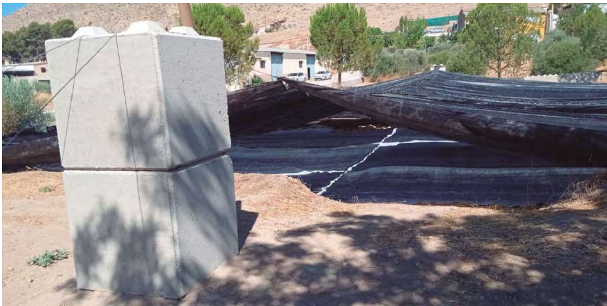
Fig. 7 Detalle de la protección de los restos con geotextil y cubierta provisional de lona. Autor J.J. Álvarez.
