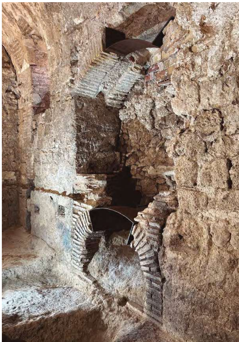
Fig. 2: Instalación de pletinas metálicas en las faltas de los arcos de fábrica de ladrillo del horno y del espacio de la caldera para garantizar su estabilidad.
