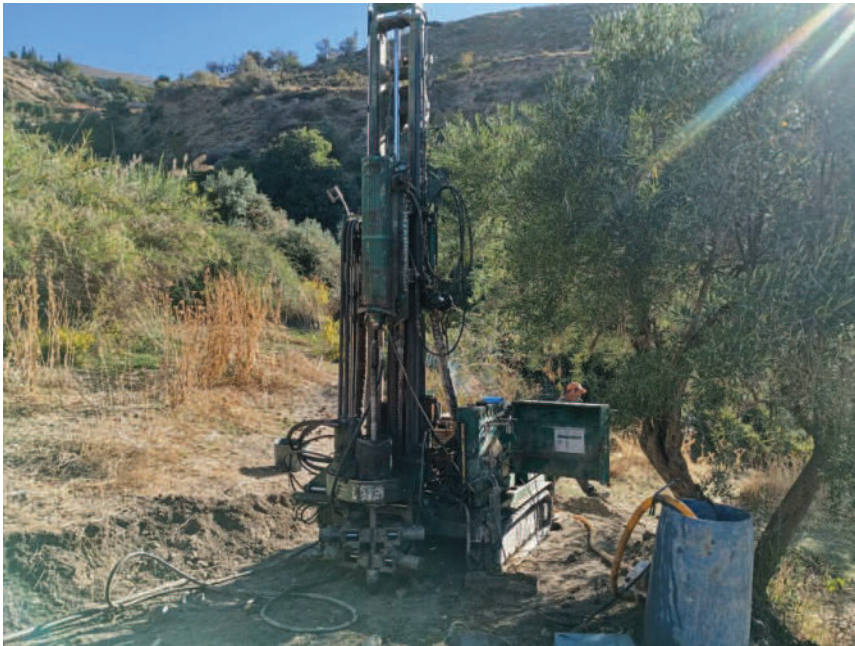
Figura Nº 19.- Imagen de la ejecución del sondeo mecánico y rotativo con extracción continua de testigo referido como S-02
