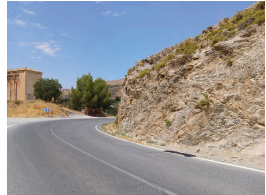
Figura Nº 9.- Vista del talud existente en la curva del p.k. 0+240 de proyecto.
