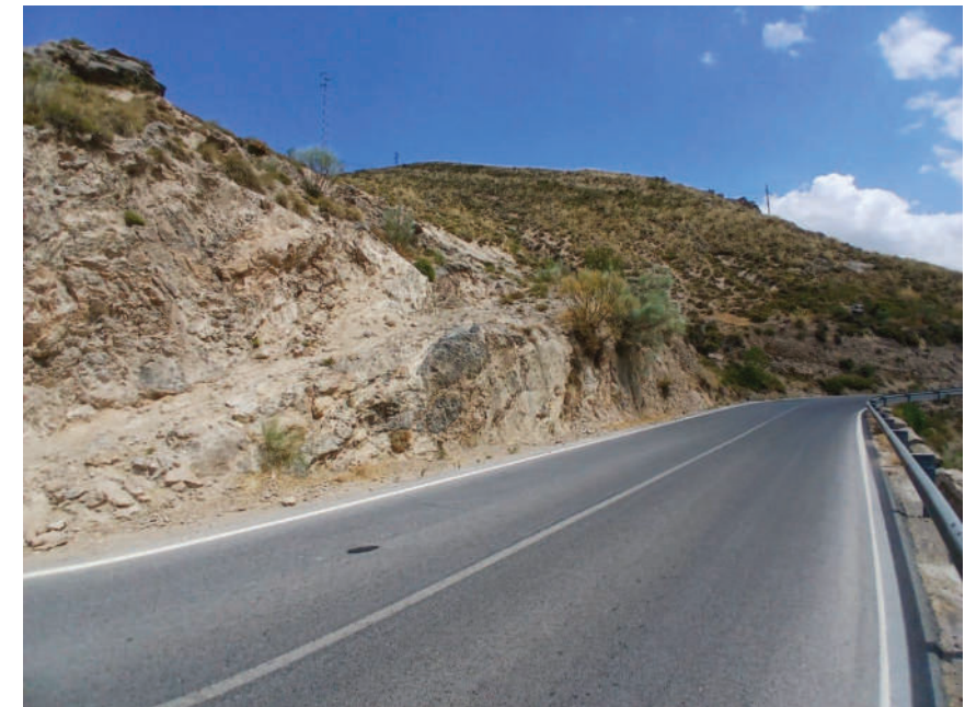
Figura Nº 10.- Vista del talud existente en la zona donde se ha realizado el sondeo S-01, coincidiendo con el p.k. 0+240 de proyecto.
