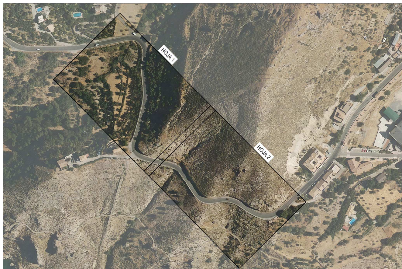
Tramo de proyecto de mejora local.
