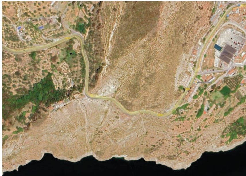
Figura Nº 7.- Imagen aérea de la zona del tramo de la GR-3200 en los que se va a actuar.
