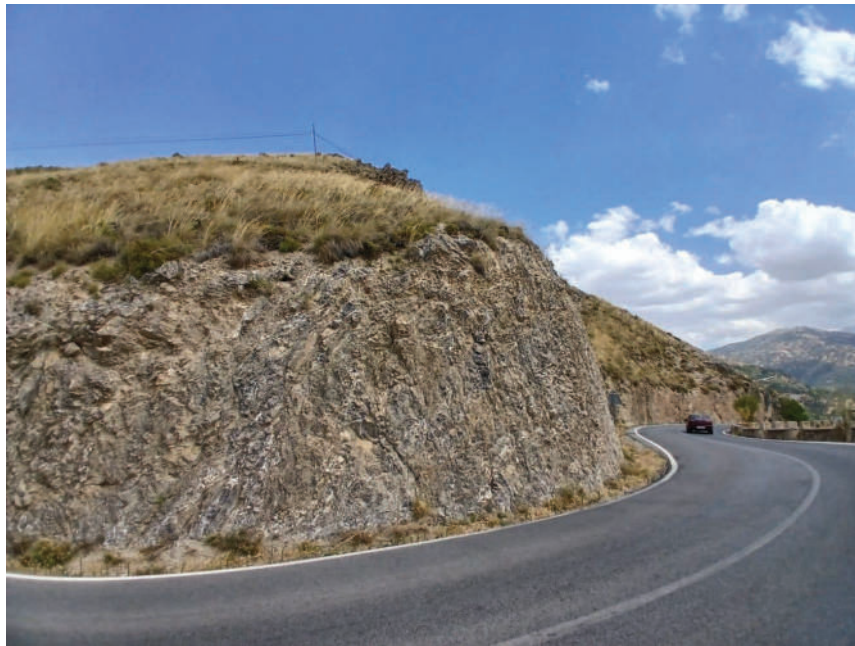
Figura Nº 11.- Vista del talud existente en la curva del p.k. 0+340 de proyecto.
