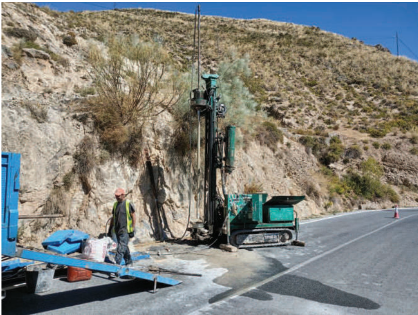
Figura Nº 18.- Imagen de la ejecución del sondeo mecánico y rotativo con extracción continua de testigo referido como S-01
