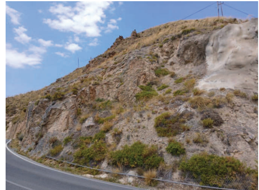
Figura Nº 13.- Vista del talud existente a la entrada del municipio de Güejar Sierra fuera del tramo de actuación.
