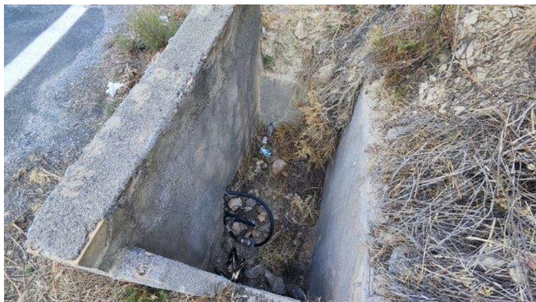
Vista de la tubería de abastecimiento existente bajo la cuneta.
