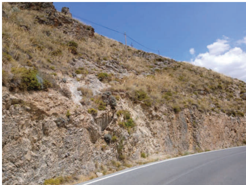
Figura Nº 12.- Vista del talud existente en la curva del p.k. 0+340 de proyecto.
