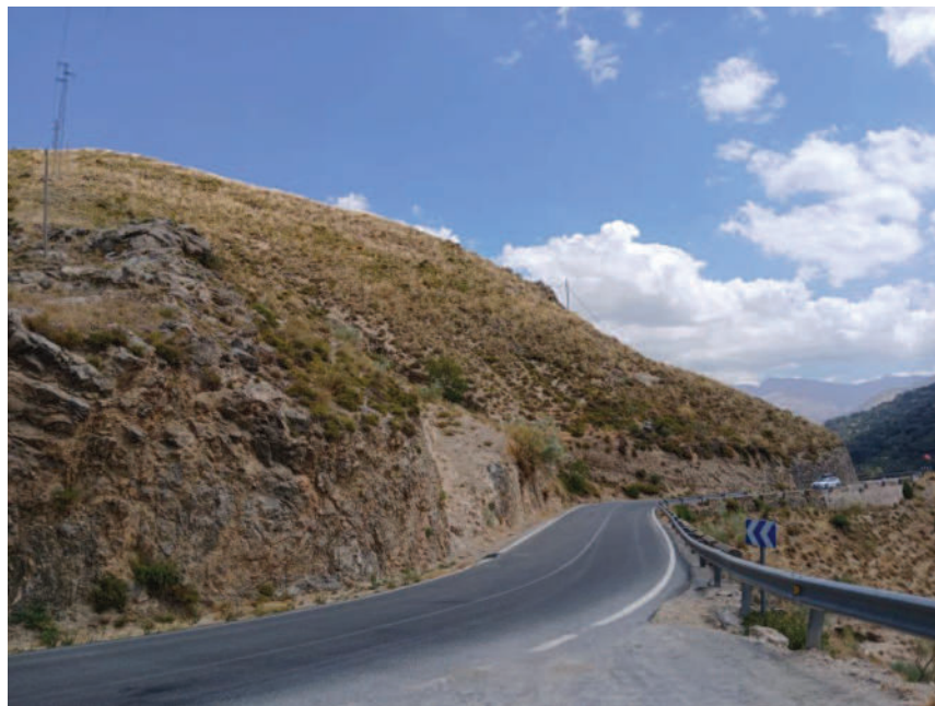
Figura Nº 8.- Vista del talud existente en la curva del p.k. 0+160 de proyecto.
