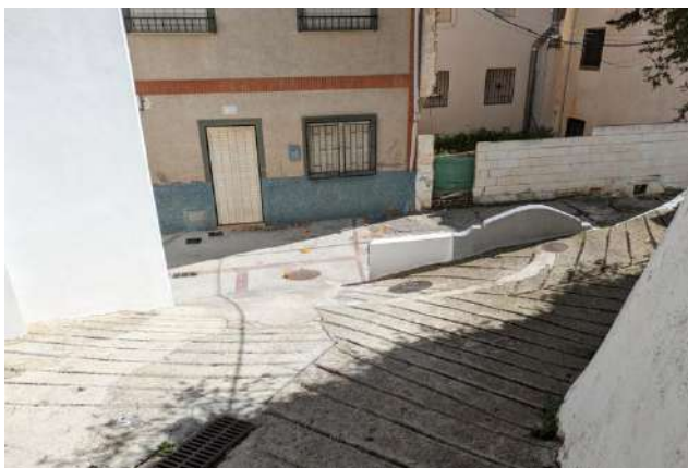
Imagen desde el vial que sube al Pedregal mirando hacia la calle Estación, donde se observa como el pilar de agua está situado en una posición que no permite realizar con facilidad la curva a derechas. En esta zona será necesario realizar rellenos de grava y demoliciones de hormigón del pavimento para realizar un nuevo rasanteo del punto de encuentro entre ambos viales.
