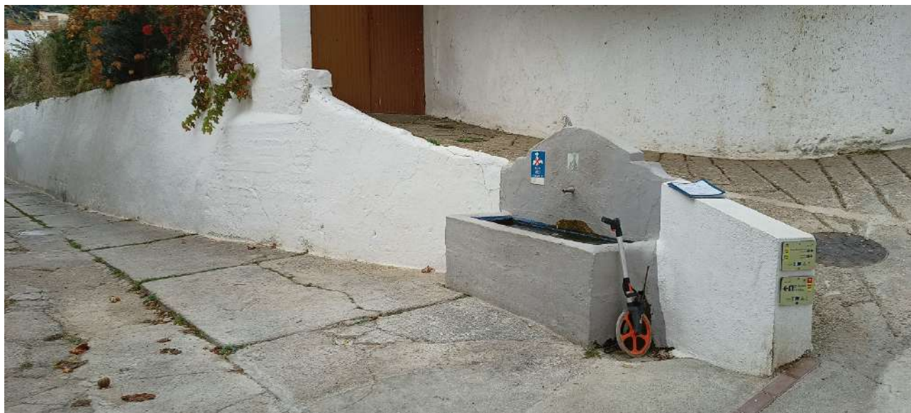
PILAR EXISTENTE EN EL INICIO DE LA ACTUACIÓN
