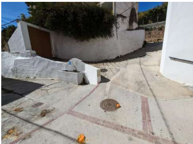
Imagen de la curva que hay que rasantear y ampliar, desplazando el pilar-fuente de agua para enlazar con más anchura el vial que sube al Pedregal con la calle Estación.
