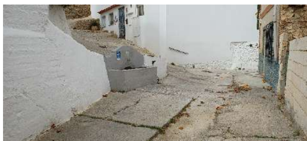
Roturas en calzada provocadas por filtraciones y averías
