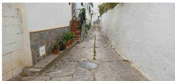
Roturas en calzada provocadas por filtraciones y averías
