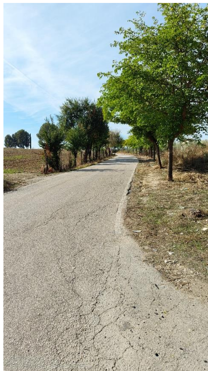
VISTA GENERAL ESTADO PAVIMENTO
