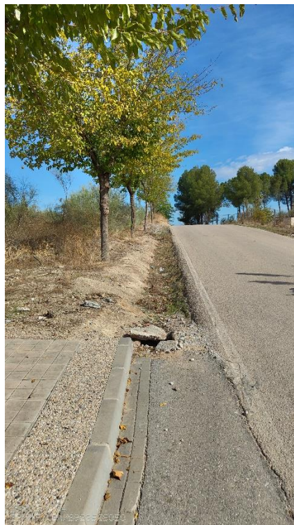
VISTA GENERAL ESTADO CUNETAS
