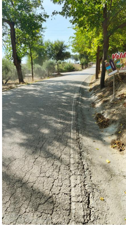
VISTA GENERAL ESTADO PAVIMENTO
