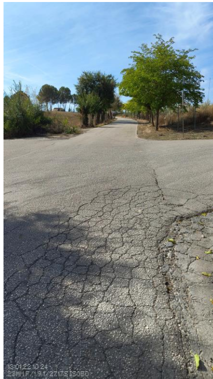
VISTA GENERAL ESTADO PAVIMENTO
