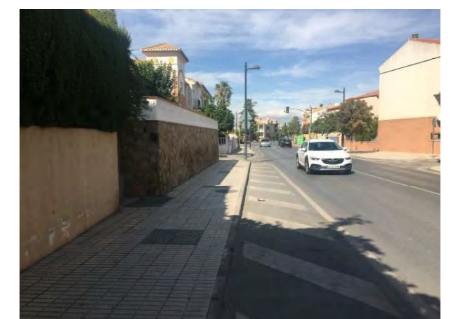
Vista general del Tramo 1 en D.O. 0+800
