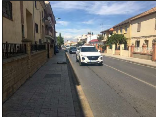
Vista general del Tramo 2 en D.O. 1+000
