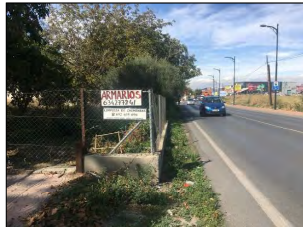
Vista general del Tramo 1 en D.O. 0+280
