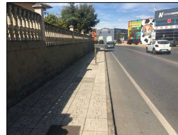
Vista general del Tramo 1 en D.O. 0+420
