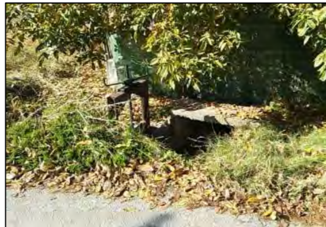
Acequia existente entre D.O. 0+260 y D.O. 0+330
