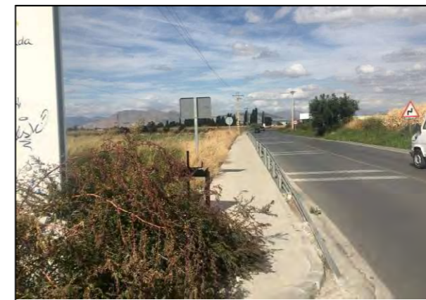
Vista general del Tramo 3 en D.O. 2+200
