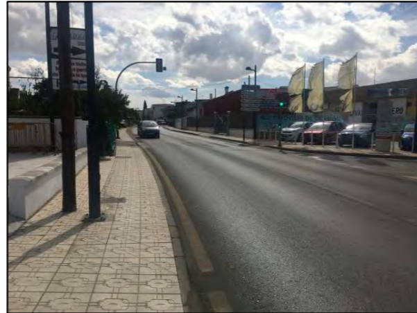
Vista general del Tramo 2 en D.O. 1+940
