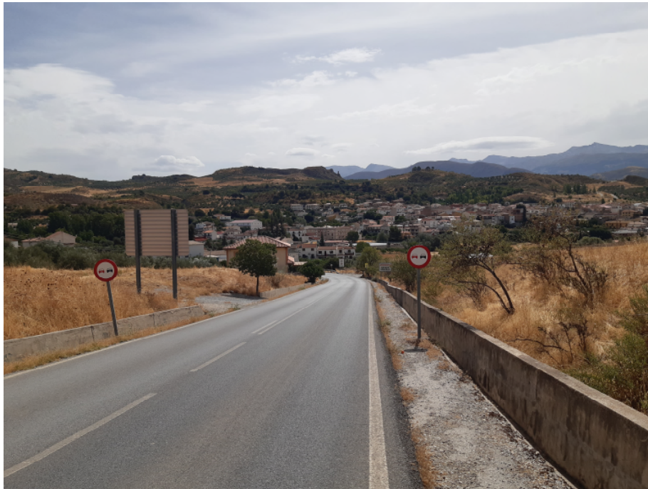
Figura Nº 2.- Imagen del vial sobre el que se realizará el ramal de giro.
