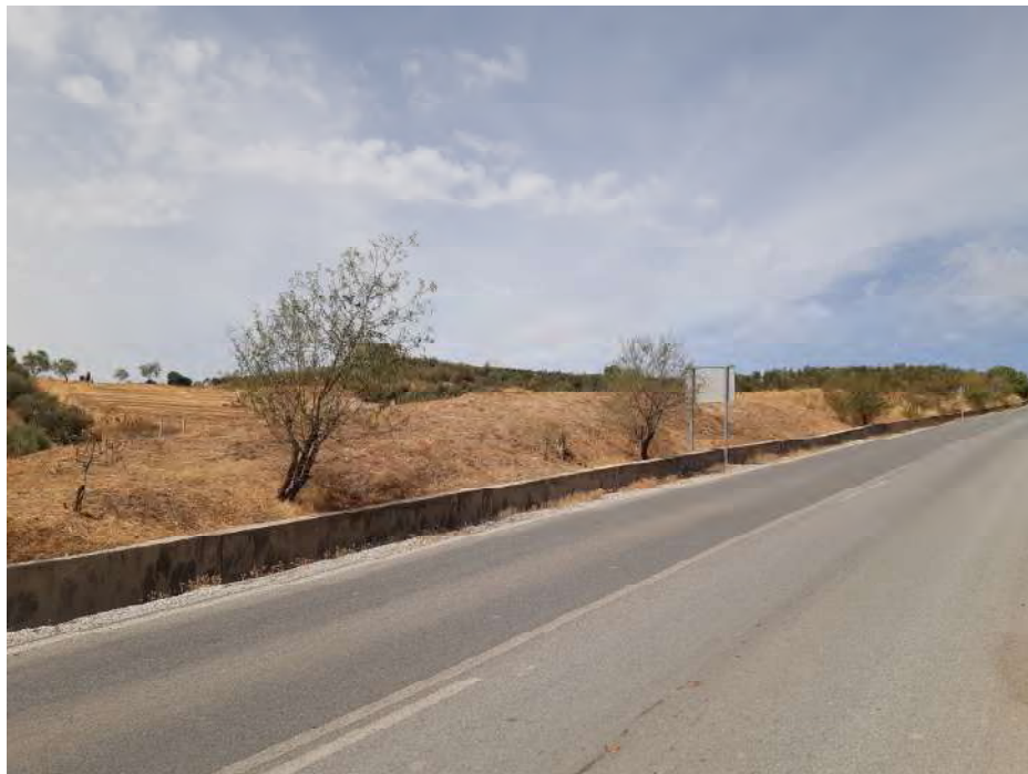
Figura Nº 3.- Diferente perspectiva del vial sobre el que se realizará la actuación.
