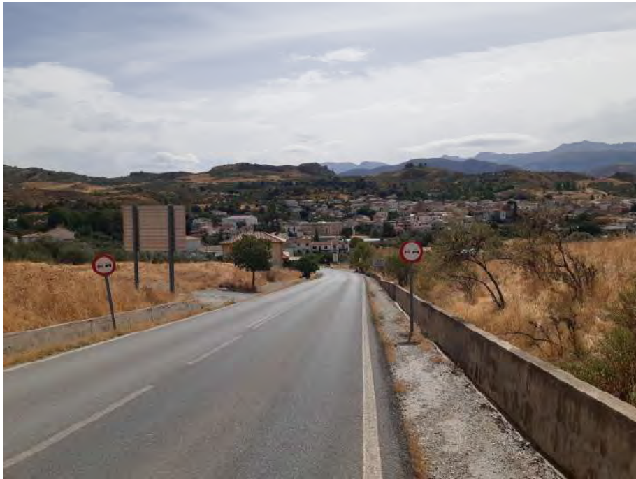
Figura Nº 2.- Imagen del vial sobre el que se realizará el ramal de giro.
