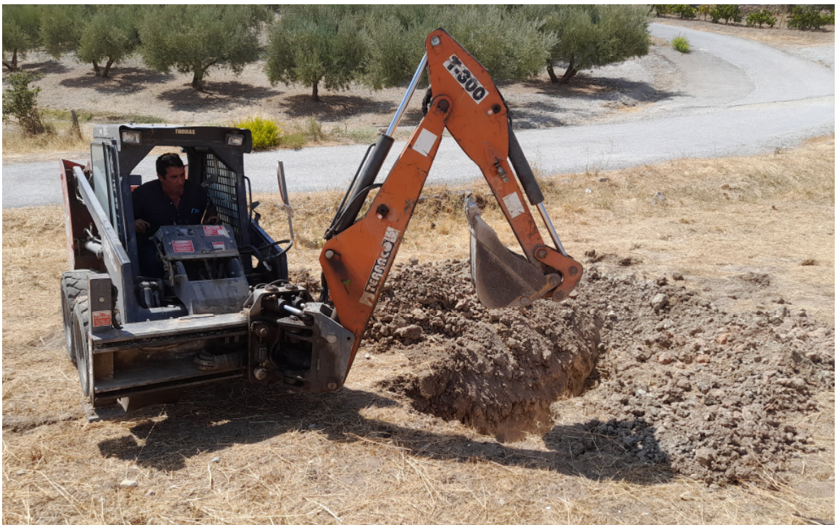
Figura Nº 6.- Fotografía de la ejecución de la calicata referida en este documento como C-02.
