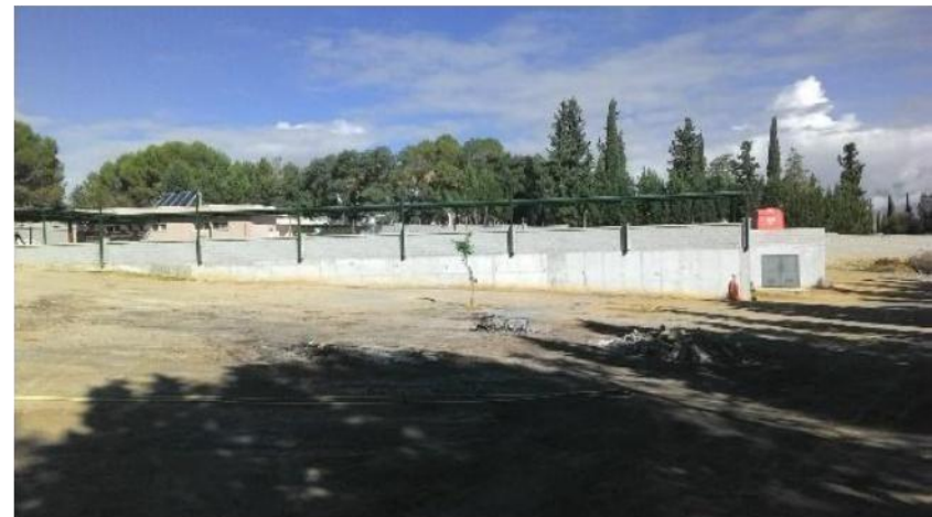
Entorno "Casa del Ingeniero"
