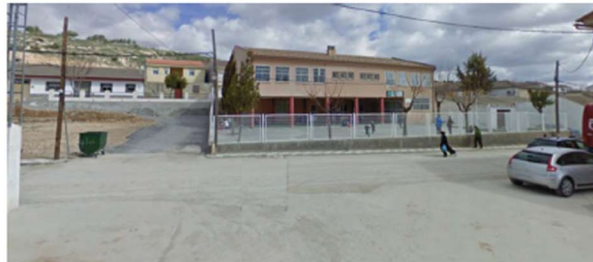
Vista de Calle Alameda. Acceso colegio
