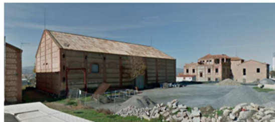
Vista actual del alzado posterior de la nave a rehabilitar
