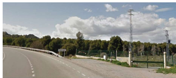
Vista acceso desde la piscina
