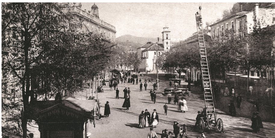
Señán González, Rafael. (fot.), Plaza Nueva [mantenimiento de un arco voltaico destinado a la iluminación pública]. 1905 ca. Tarjeta postal impresa. Colección Miguel Giménez
